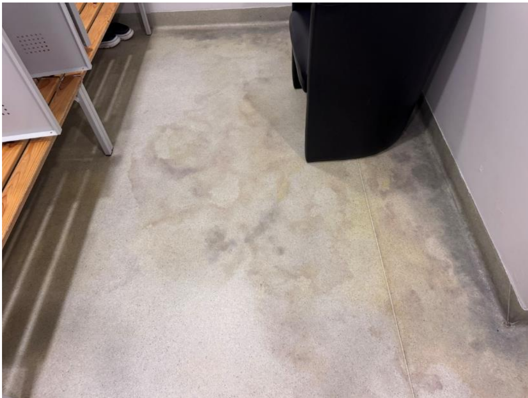
2.287 pav. Apgadinta grindų danga
