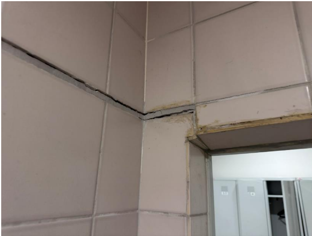
2.129 pav. Apgadinta plytelių apdaila
