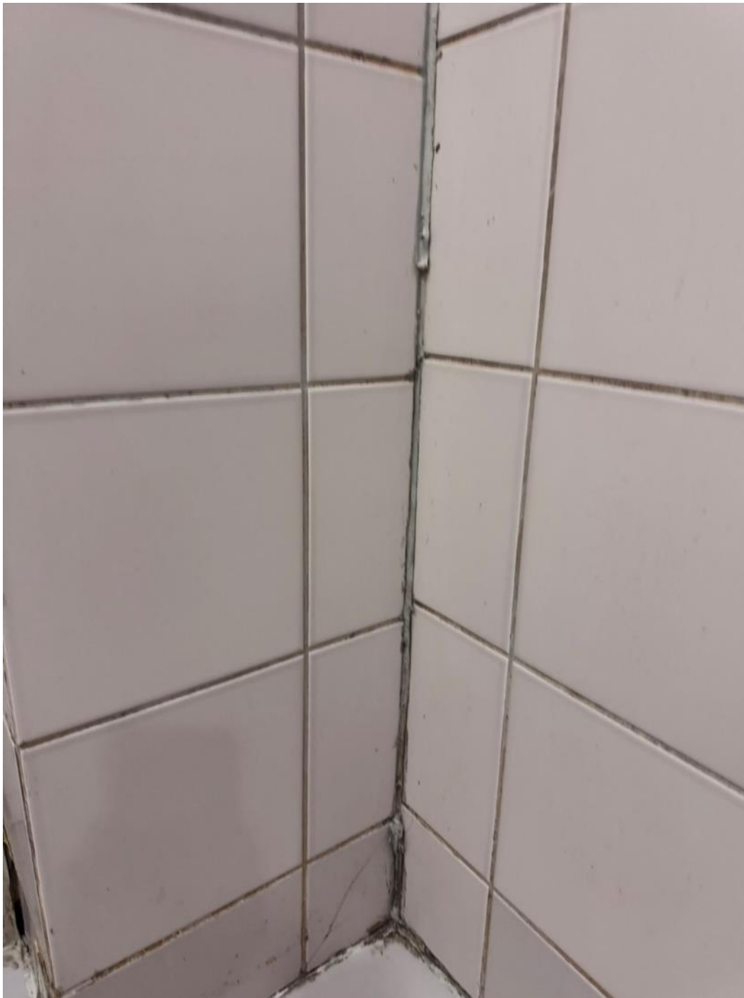
2.194 pav. Pažeistas hermetikas
