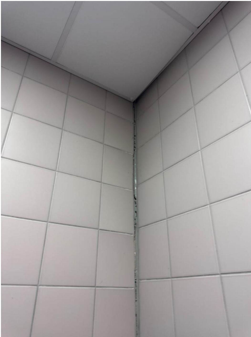
2.220 pav. Pažeistas hermetikas
