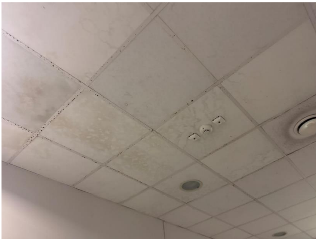
2.5pav. Drėgmės pažeistos lubos
