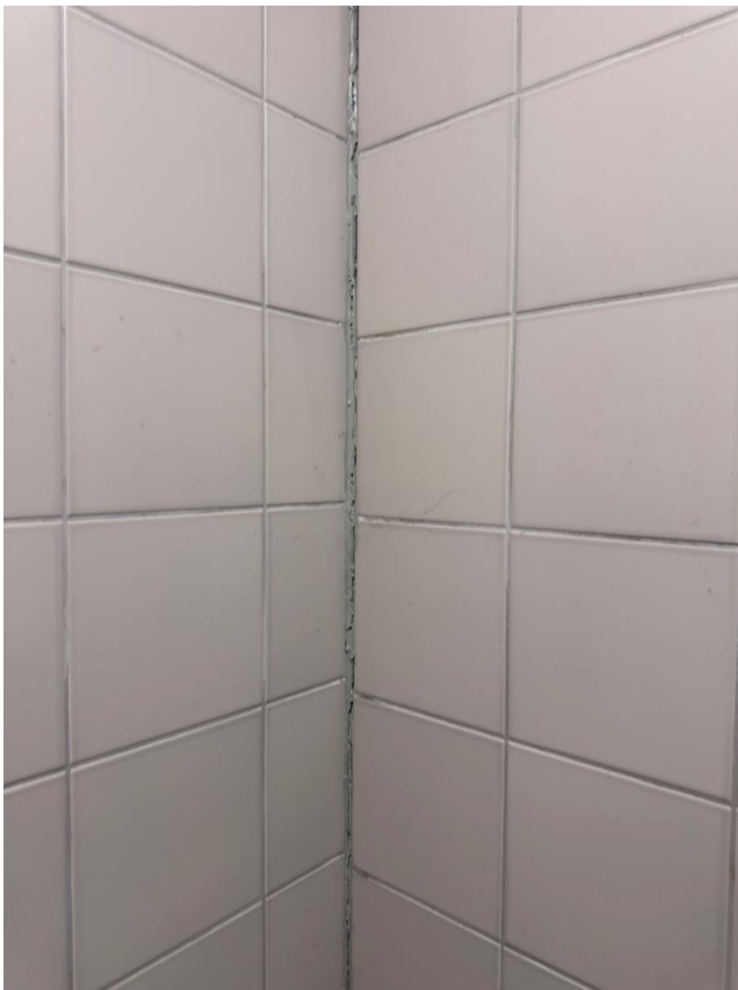
2.132 pav. Pažeistas hermetikas
