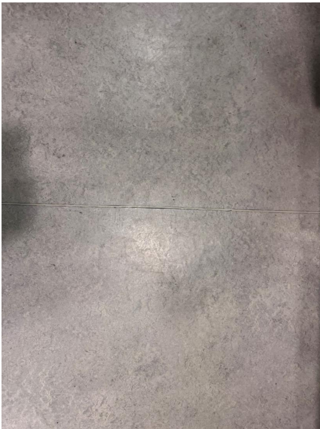
2.171 pav. Apgadintas grindų tarpo užpildas
