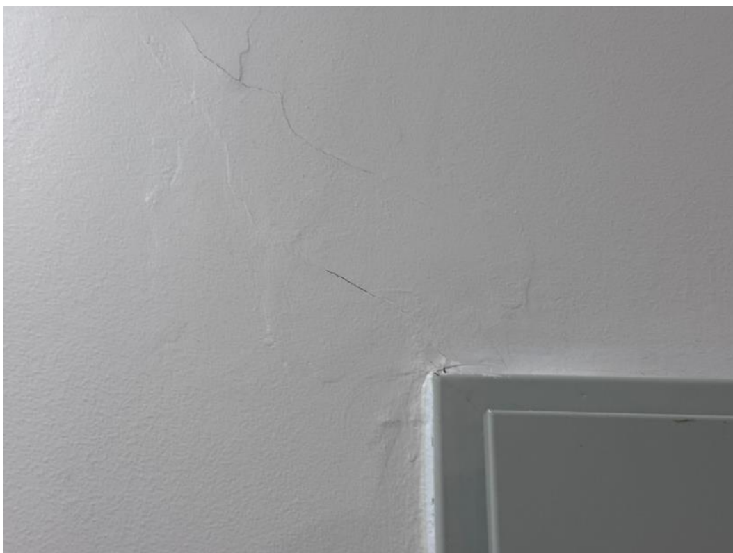
2.64 pav. Sutrūkusi sienos apdaila
