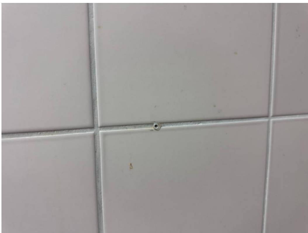
2.83 pav. Apgadinta plytelių apdaila
