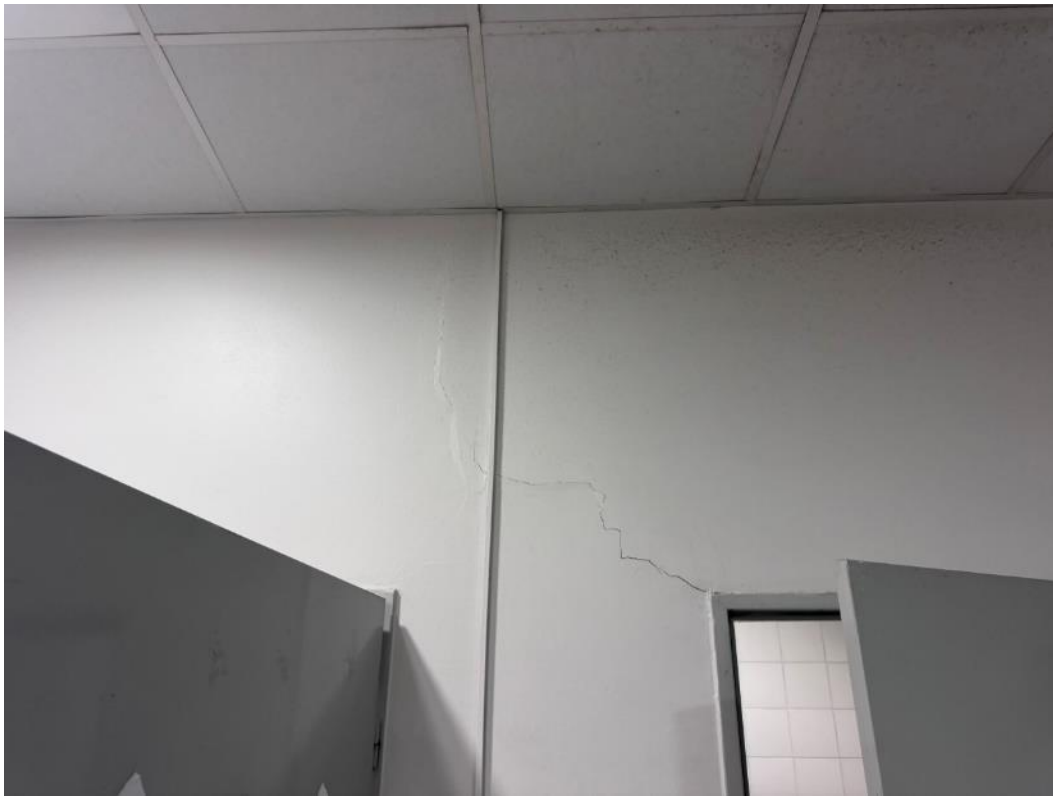
2.163 pav. Sutrūkusi sienos apdaila
