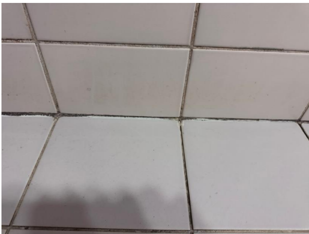
2.37 pav. Pažeistas hermetikas
