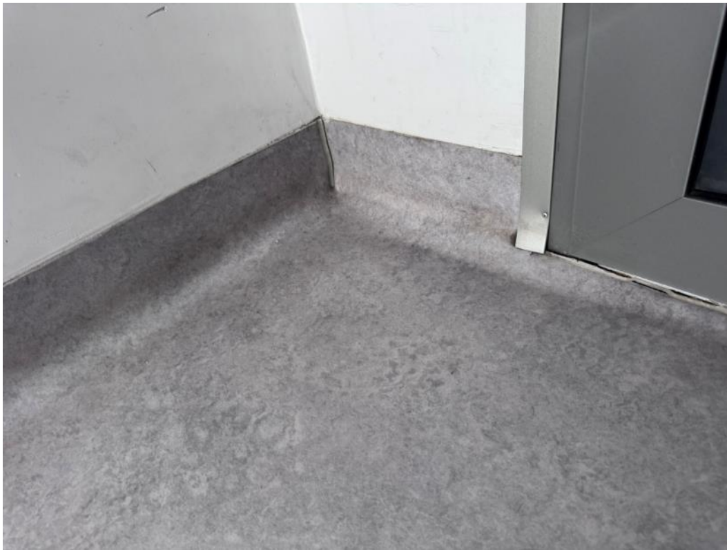
2.280 pav. Apgadintos grindjuostės
