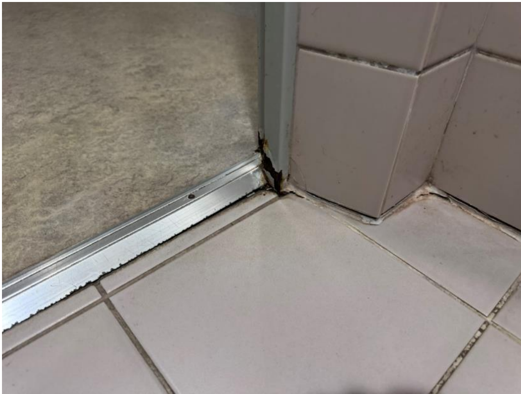
2.94 pav. Pažeistas hermetikas
