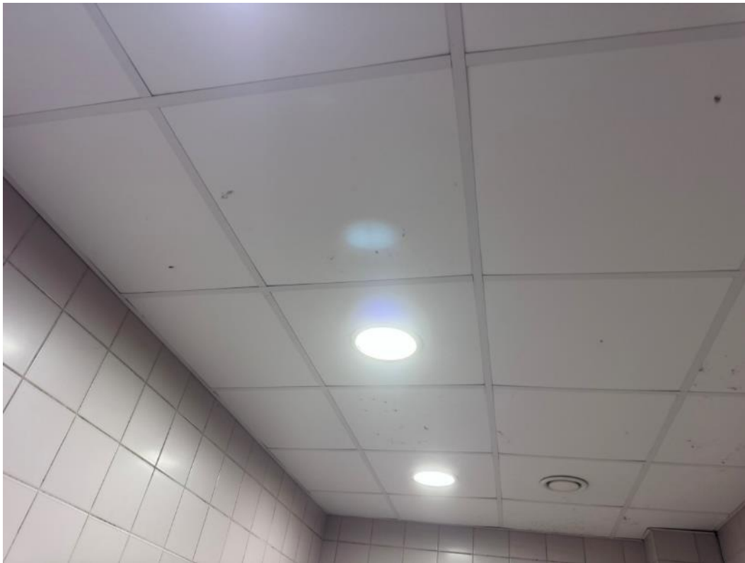
2.189 pav. Drėgmės pažeistos lubos
