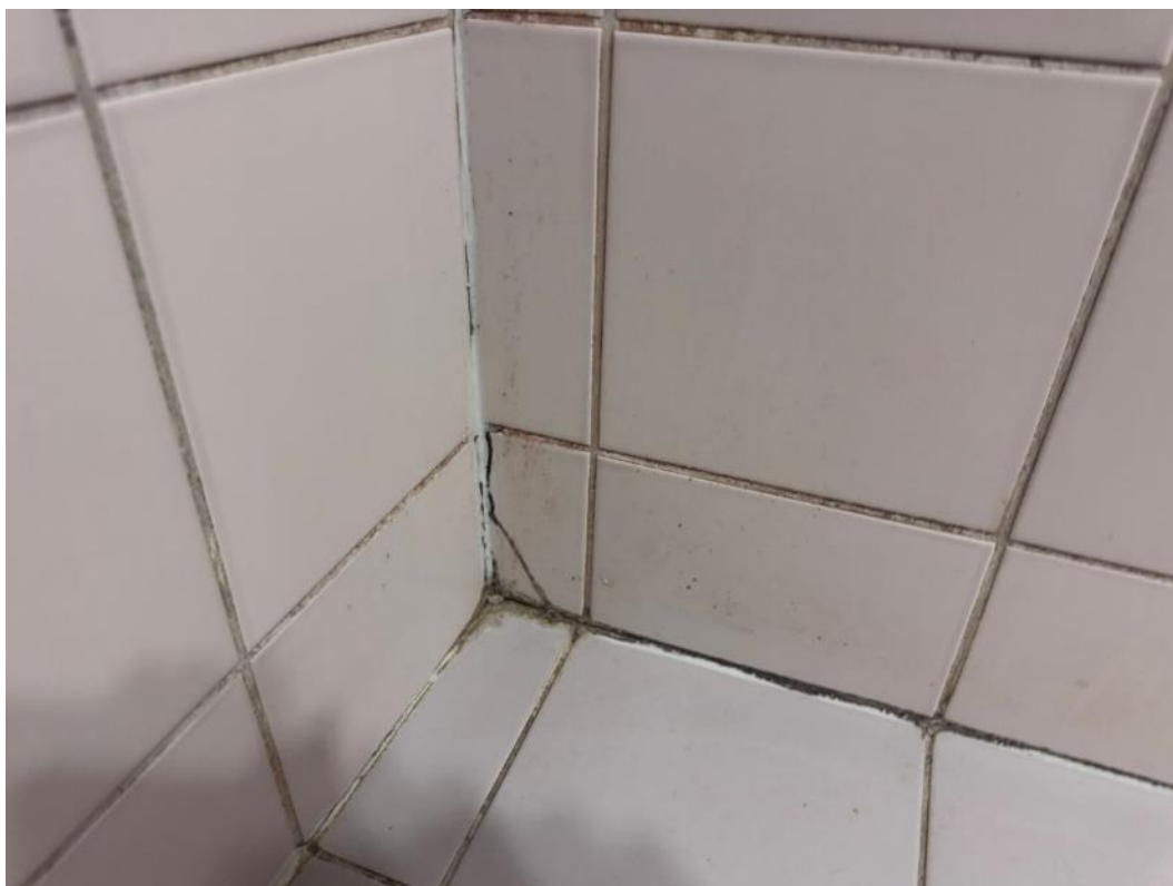
2.36 pav. Sutrūkusi plytelių apdaila
