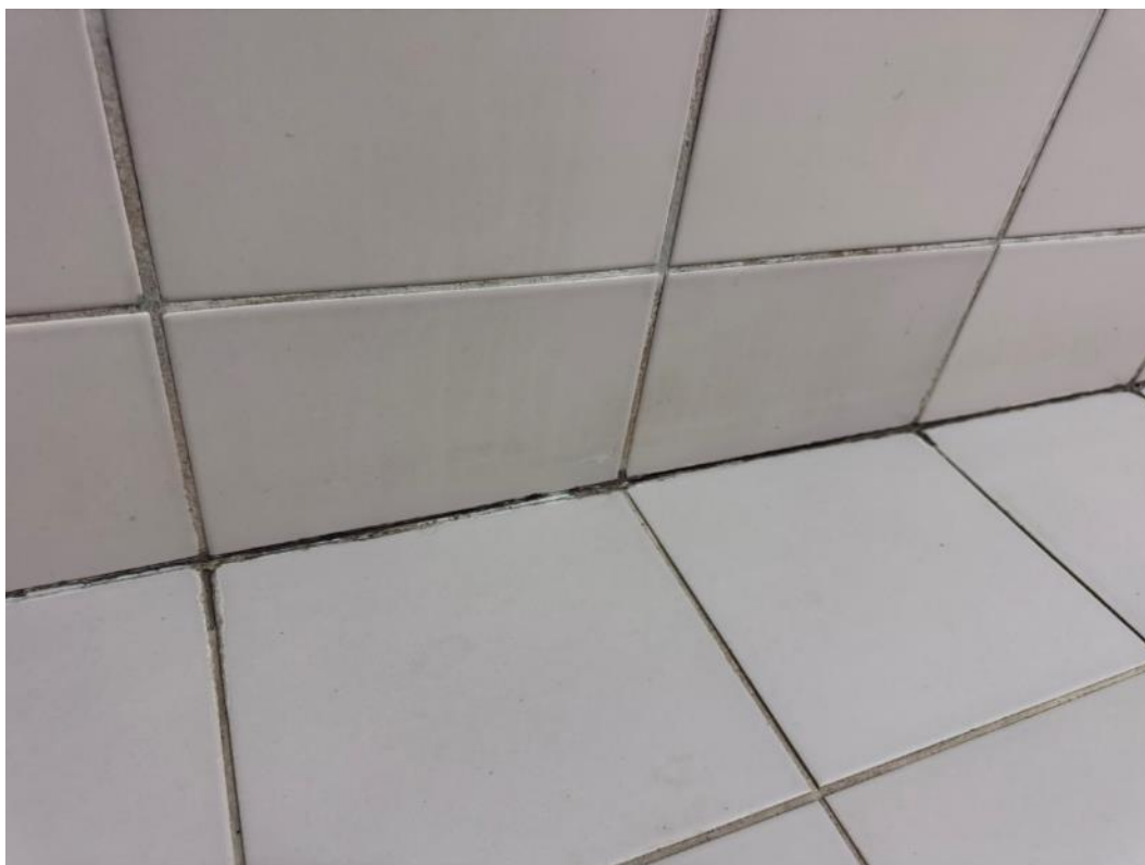
2.38 pav. Pažeistas hermetikas
