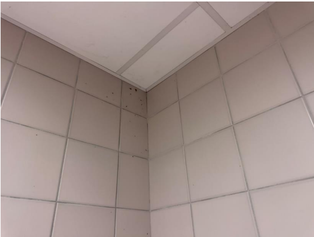
2.238 pav. Apgadinta plytelių apdaila
