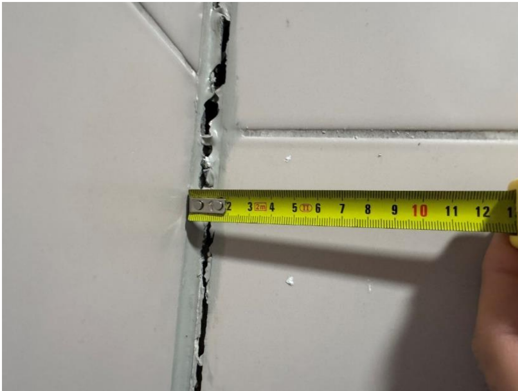
2.211 pav. Pažeistas hermetikas
