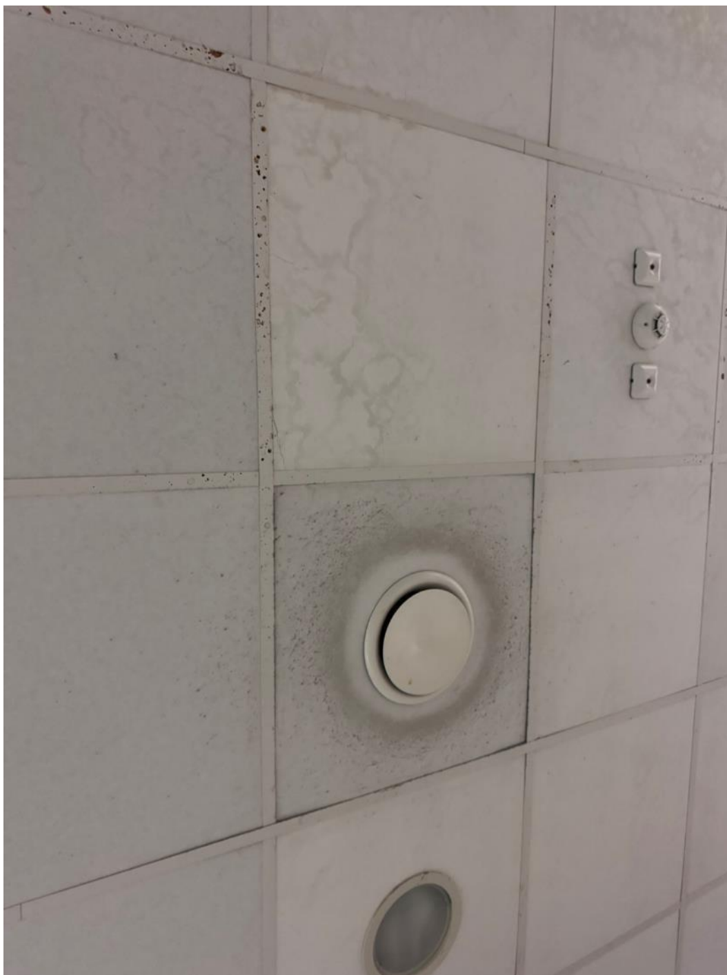
2.7 pav. Drėgmės pažeistos lubos
