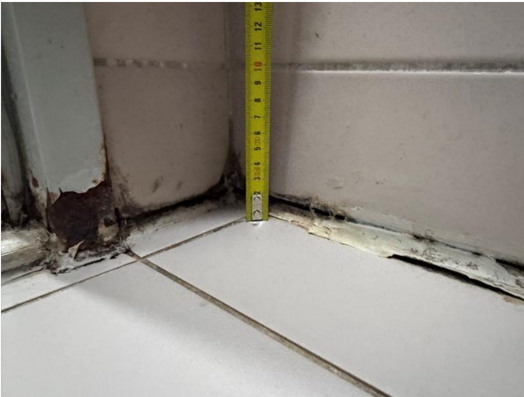
2.296 pav. Pažeistas hermetikas, susmukusios grindys
