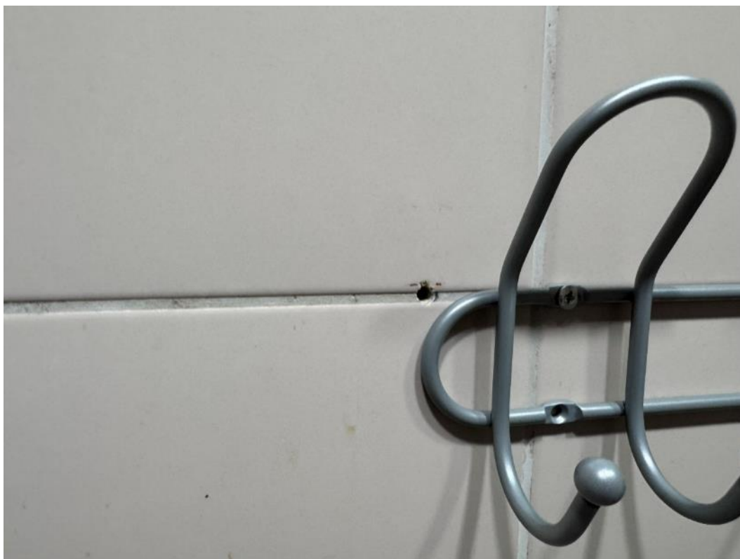
2.50 pav. Apgadinta plytelių apdaila
