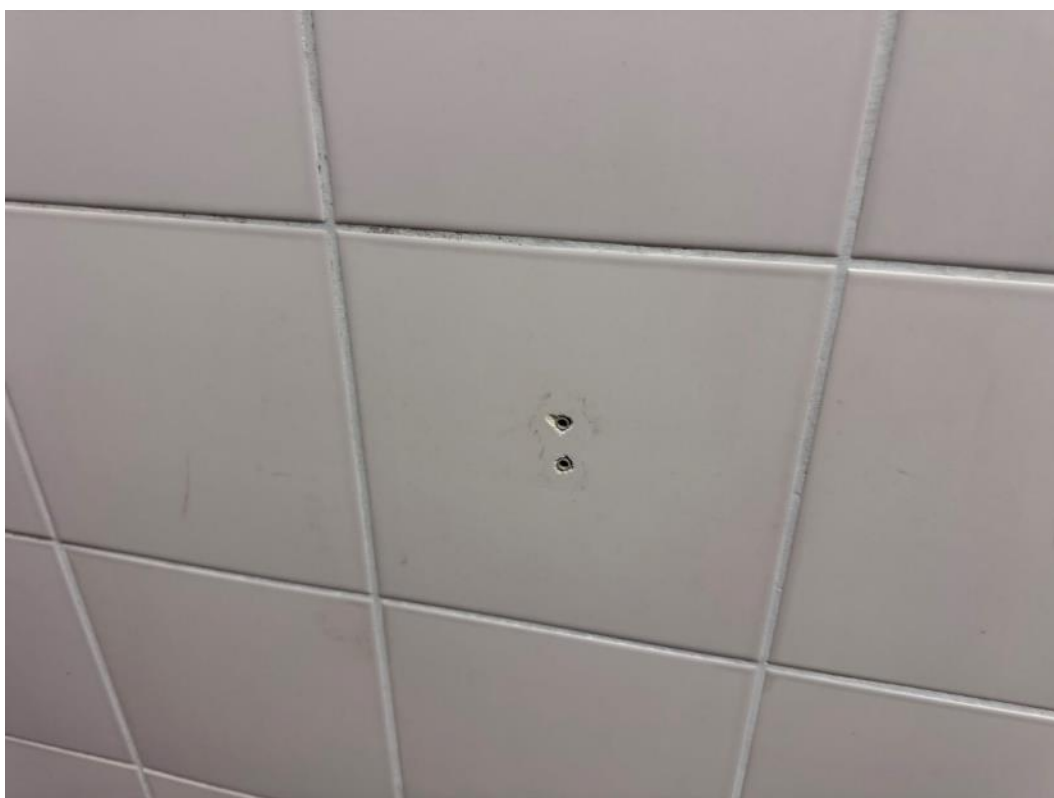
2.49 pav. Apgadinta plytelių apdaila
