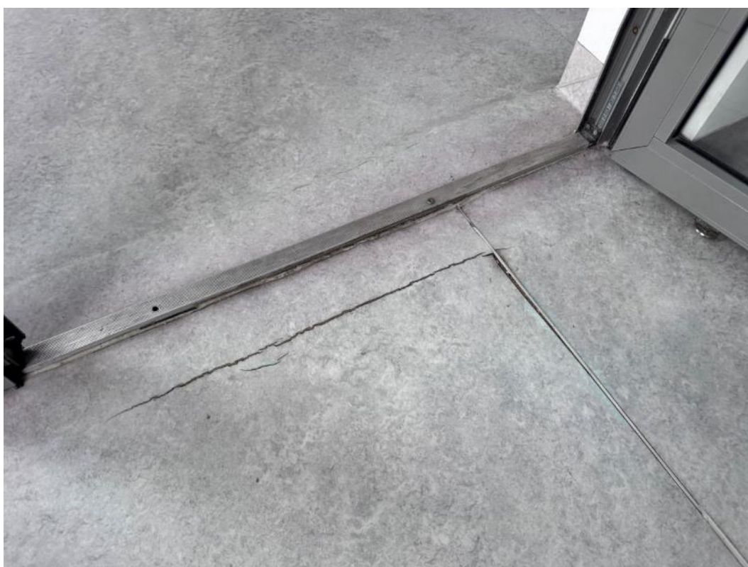
2.275 pav. Apgadinta grindų danga
