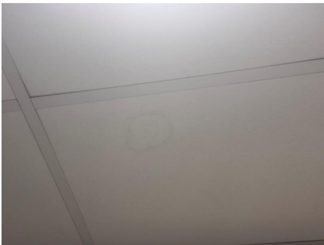
2.30 pav. Drėgmės pažeistos lubos
