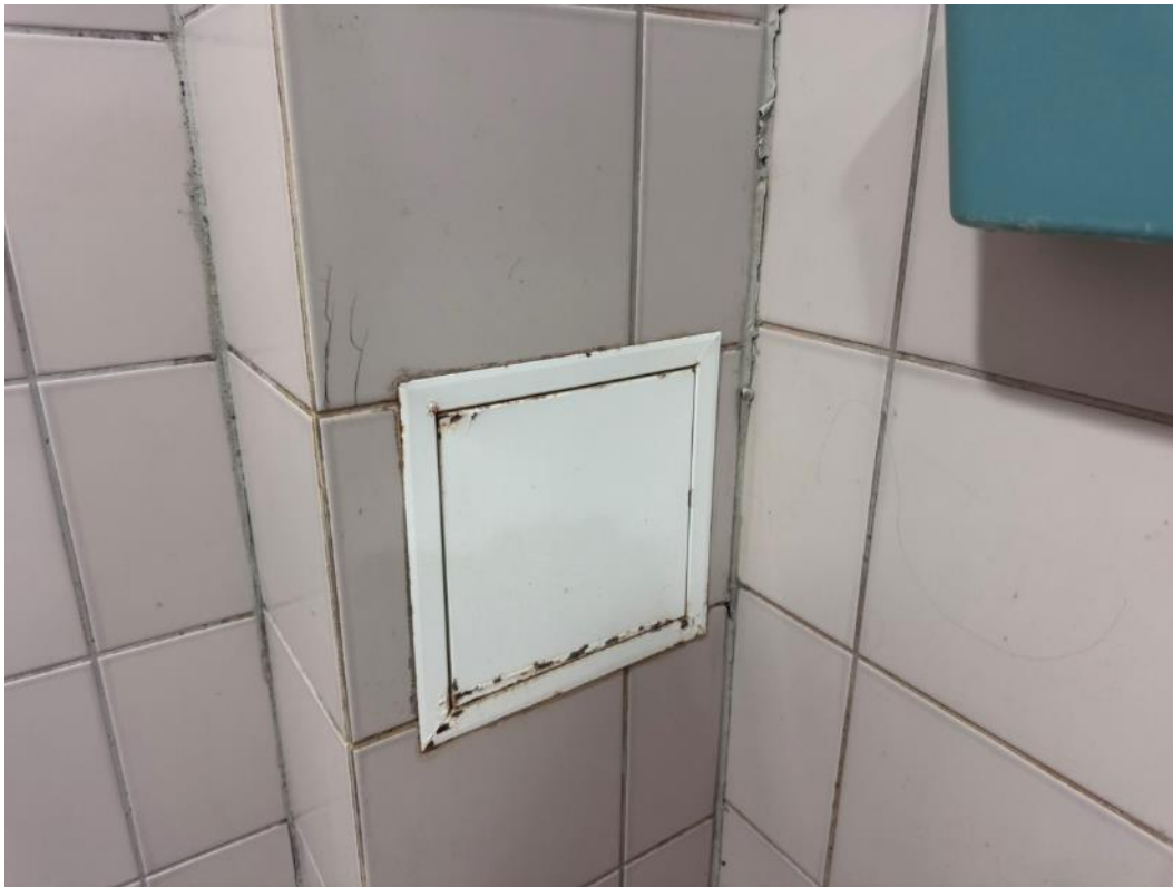
2.195 pav. Pažeistas hermetikas, korozijos paveiktos durelės
