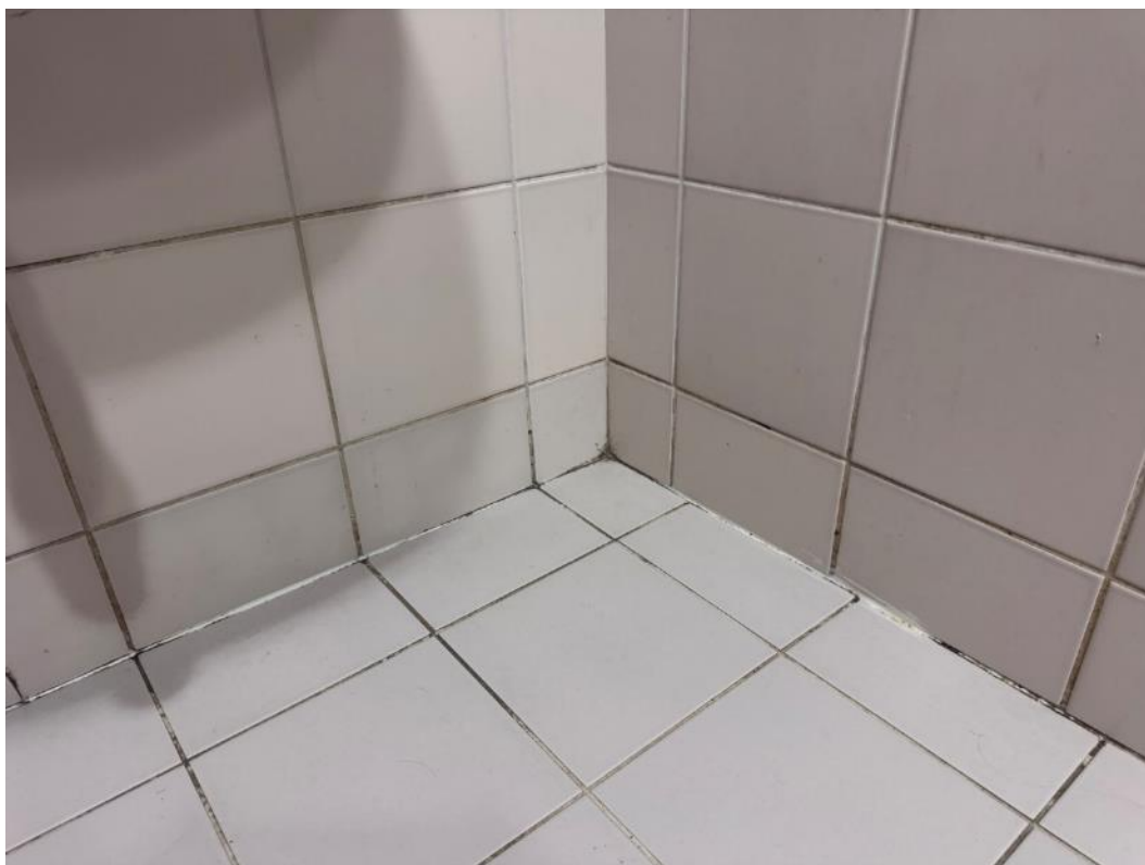
2.44 pav. Pažeistas hermetikas
