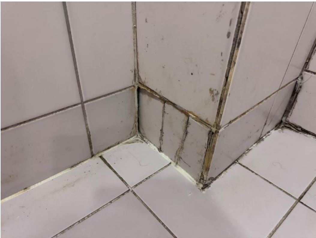
2.192 pav. Pažeistas hermetikas
