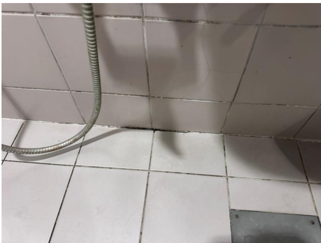
2.24 pav. Pažeistas hermetikas
