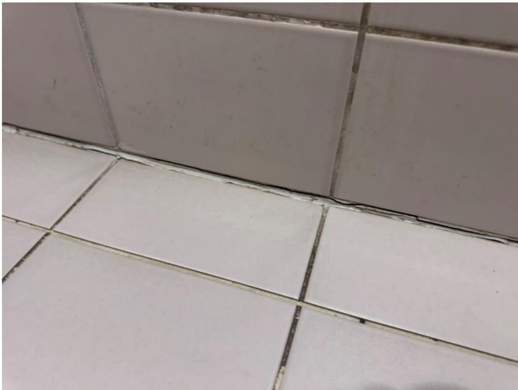
2.95 pav. Pažeistas hermetikas
