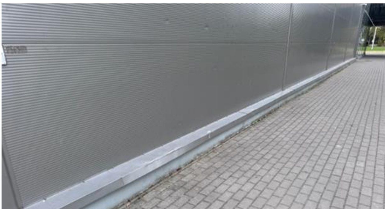
3.20 pav. Deformuotas fasadas ir cokolio apskardinimas
