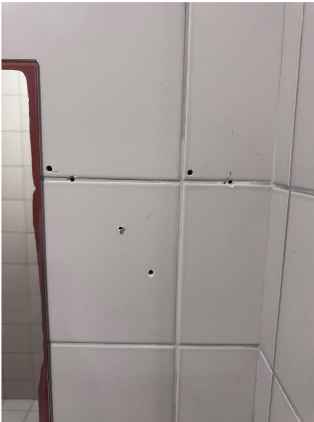
2.91 pav. Apgadinta plytelių apdaila
