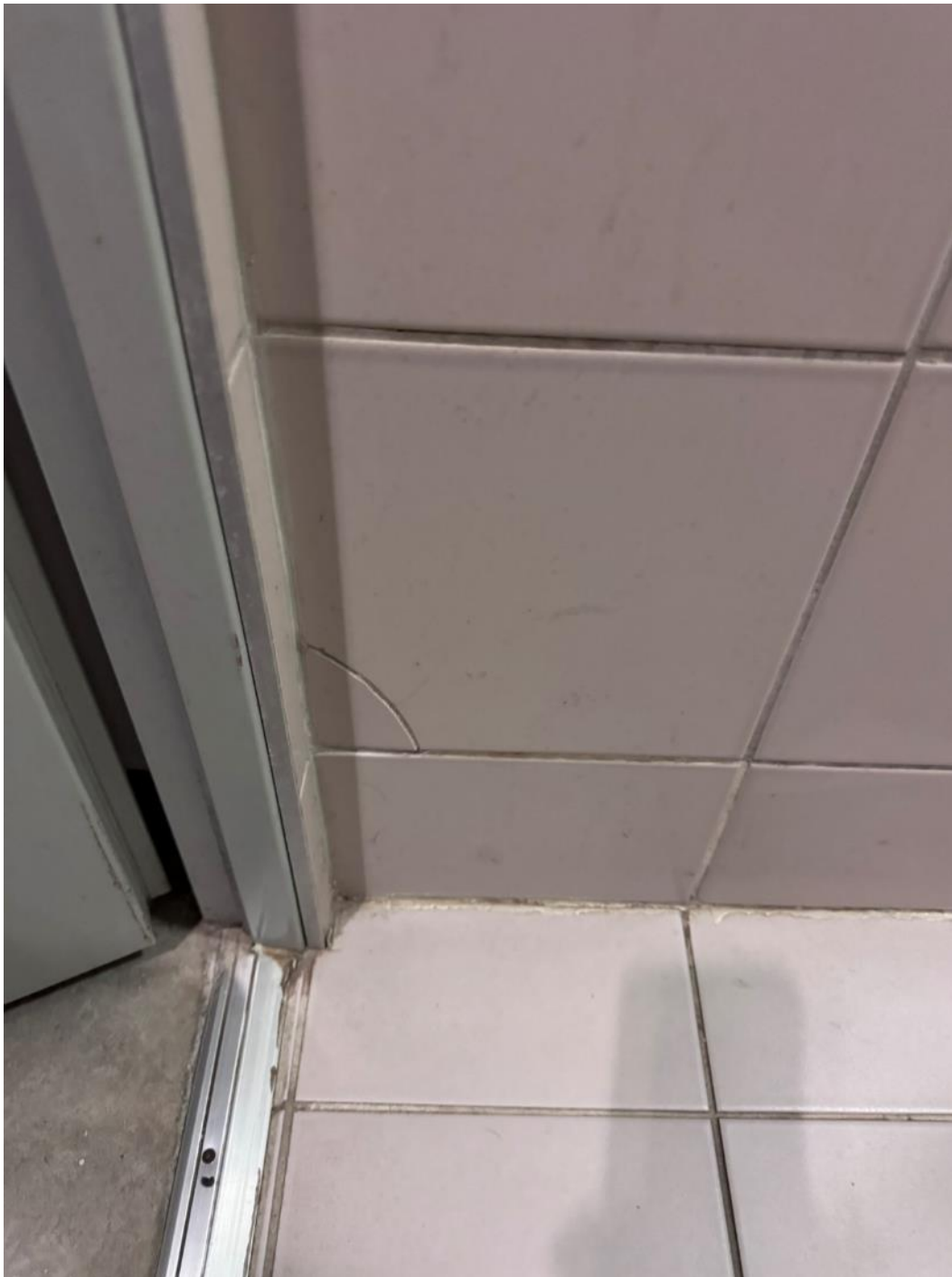
2.13 pav. Sutrūkusi plytelių apdaila
