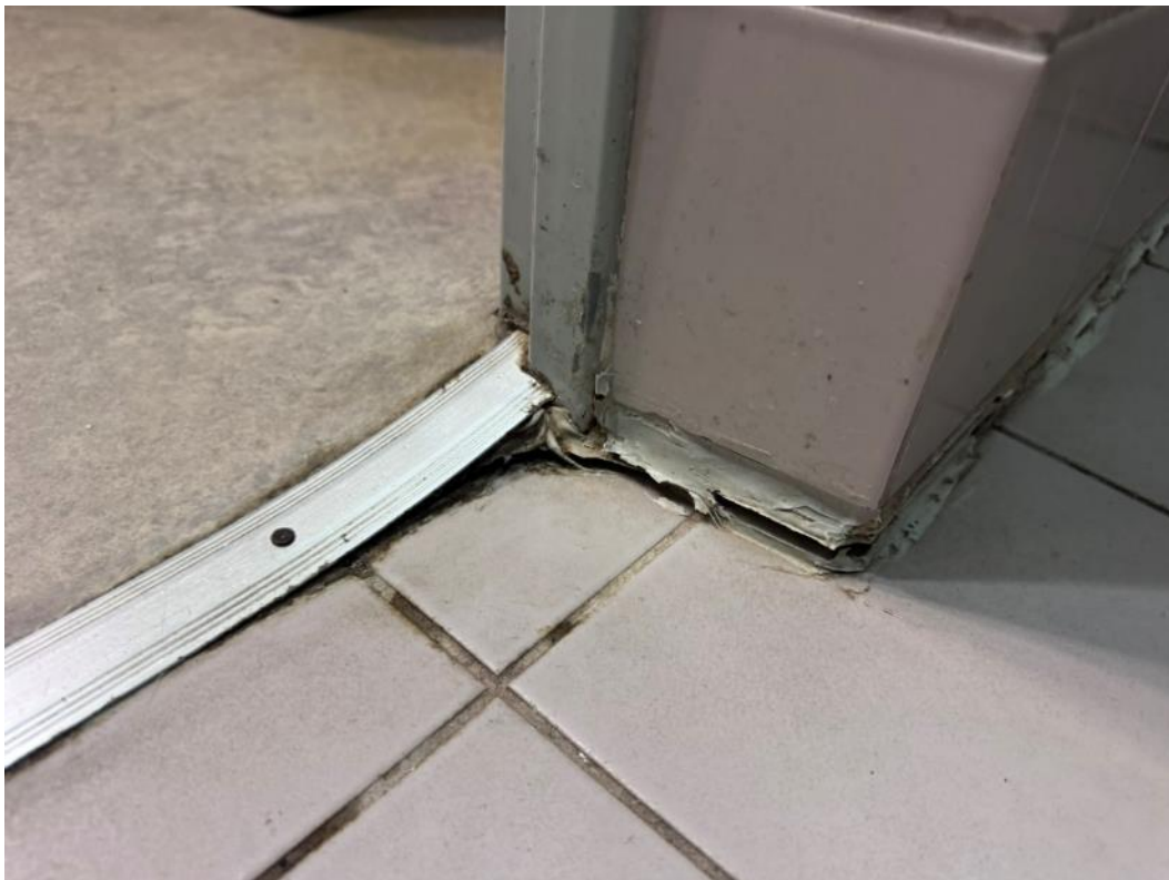
2.252 pav. Susmukusios grindys, pažeistas hermetikas
