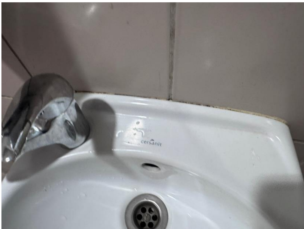
2.25 pav. Pažeistas hermetikas
