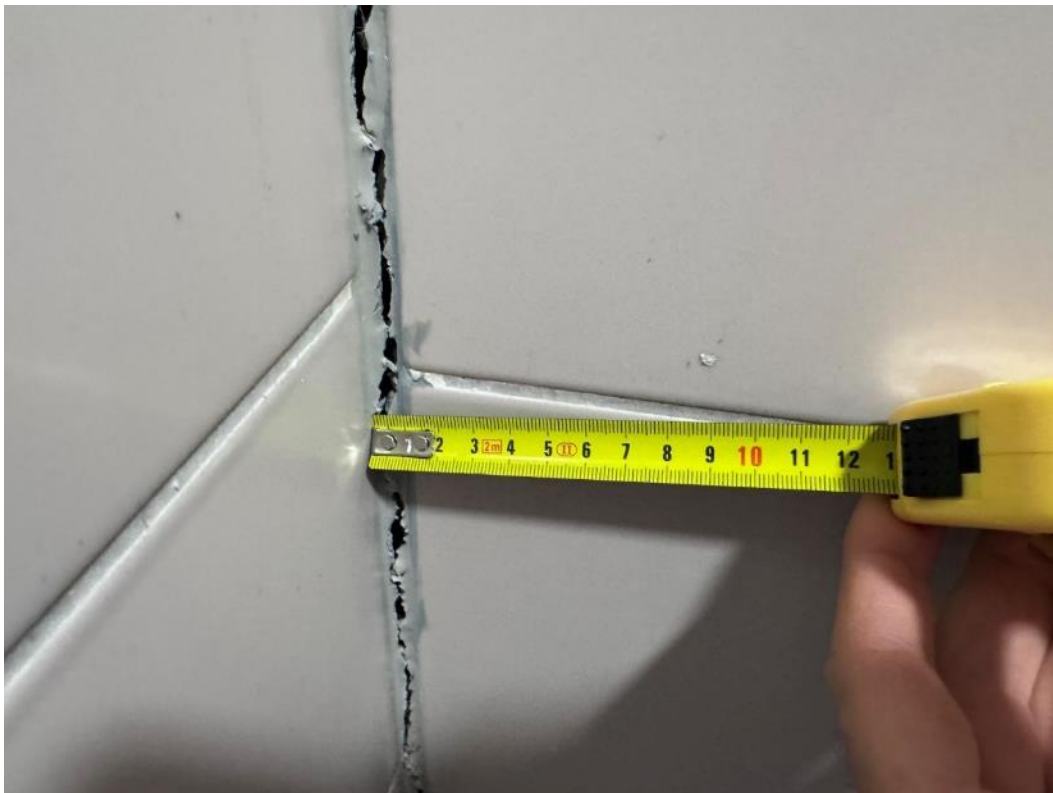
2.212 pav. Pažeistas hermetikas
