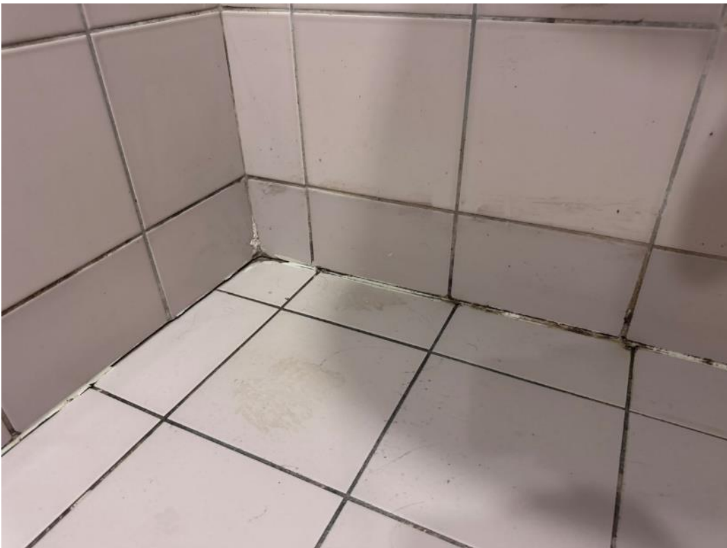
2.198 pav. Pažeistas hermetikas
