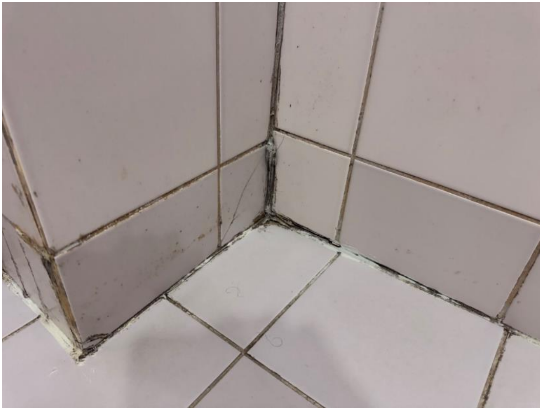
2.193 pav. Pažeistas hermetikas
