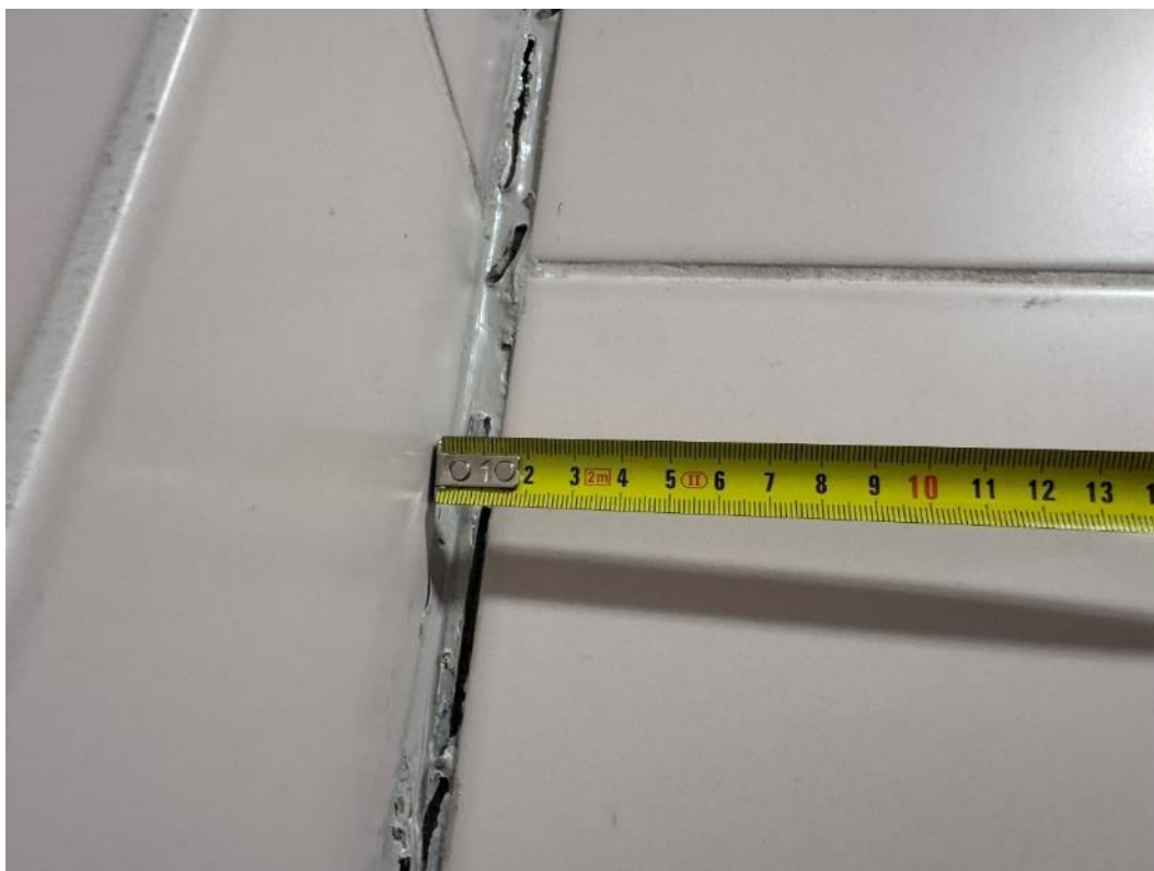
2.133 pav. Pažeistas hermetikas
