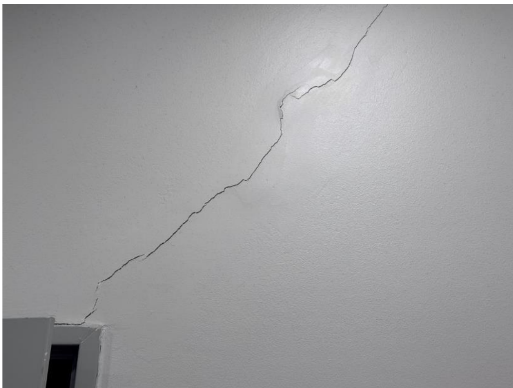
2.111 pav. Sutrūkusi sienos apdaila
