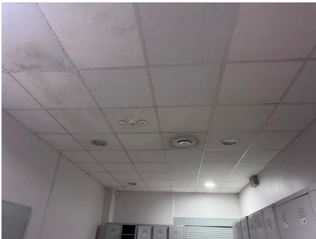
2.3 pav. Drėgmės pažeistos lubos
