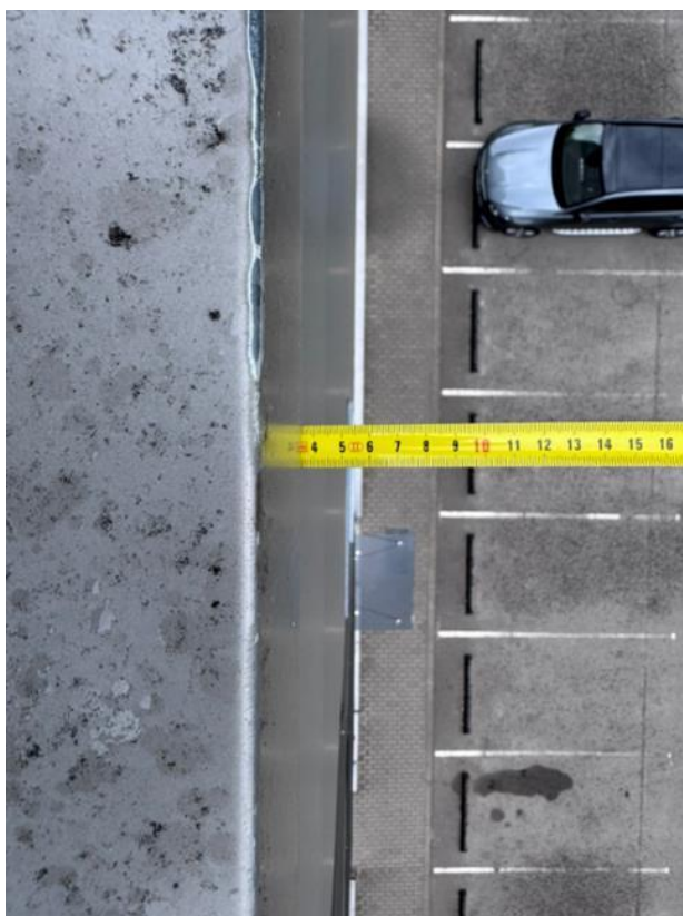
3.17 pav. Nepakankamas parapetų skardos iškišimas
