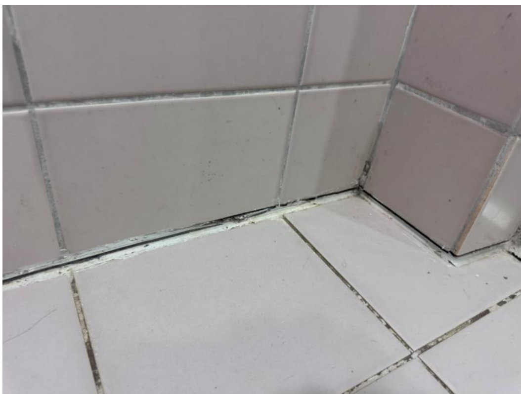
2.75 pav. Pažeistas hermetikas
