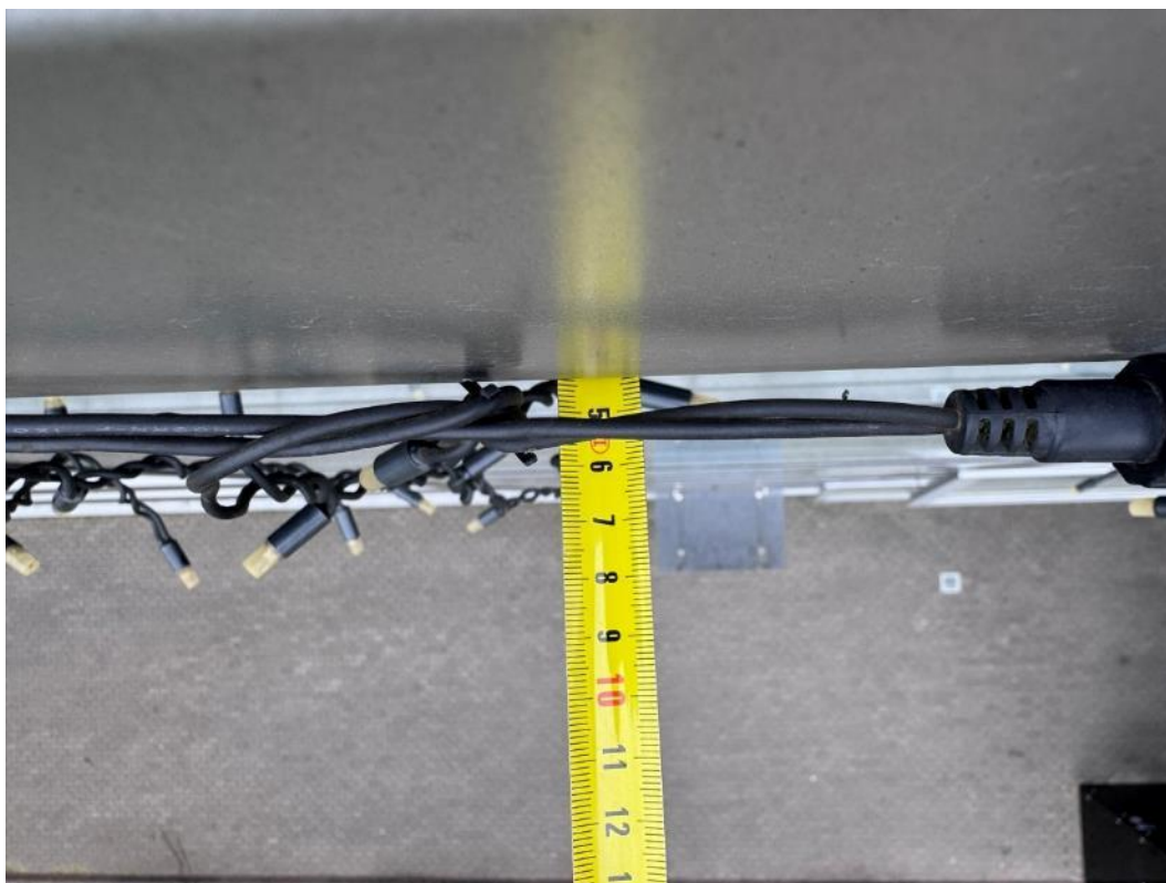
2.368 pav. Apskardinimo išsikišimas (~4,5cm)
