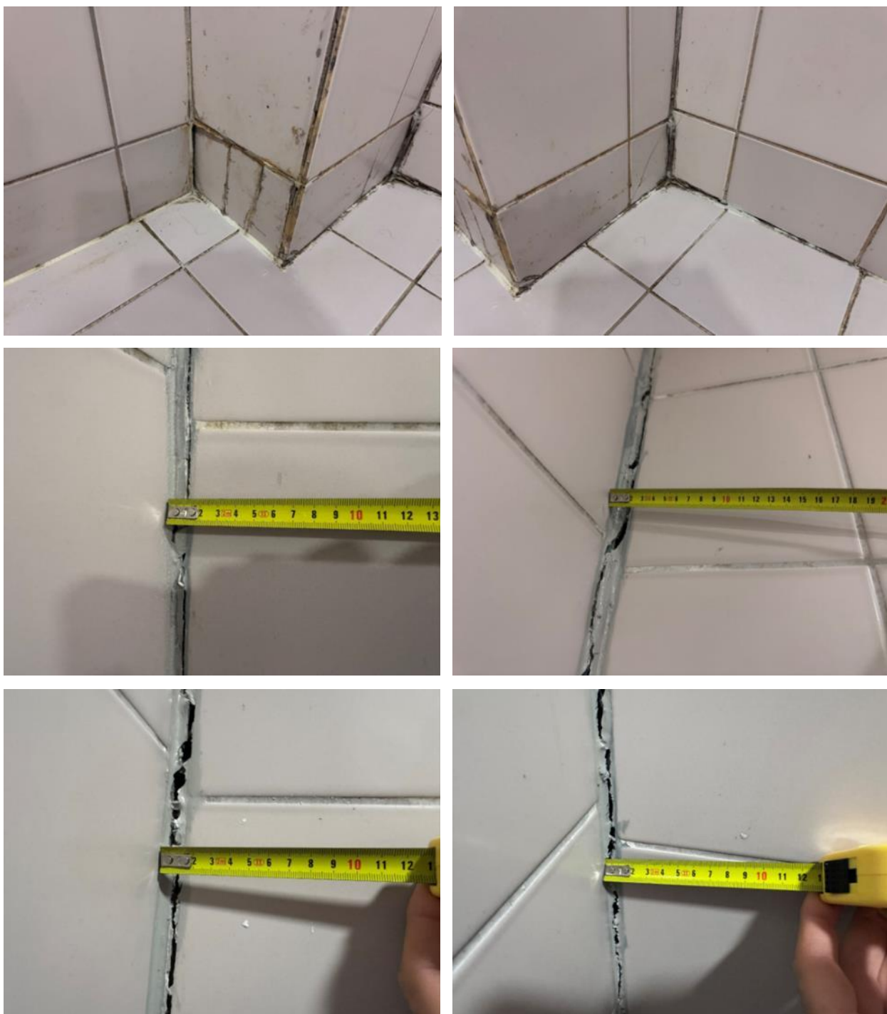
3.6pav. Pažeistas hermetikas
