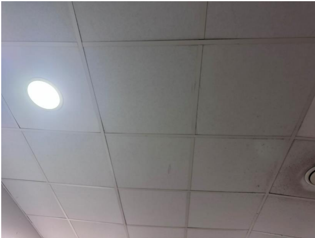
2.169 pav. Drėgmės pažeistos lubos
