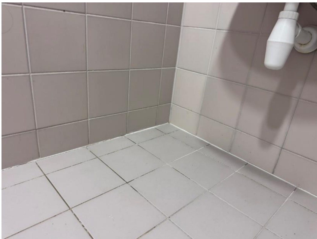
2.82 pav. Pažeistas hermetikas
