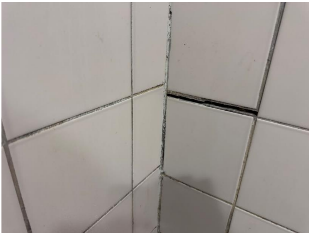
2.150 pav. Apgadinta plytelių apdaila
