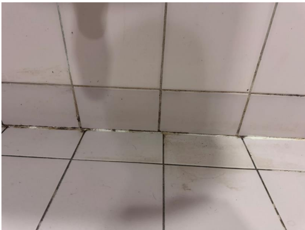
2.199 pav. Pažeistas hermetikas
