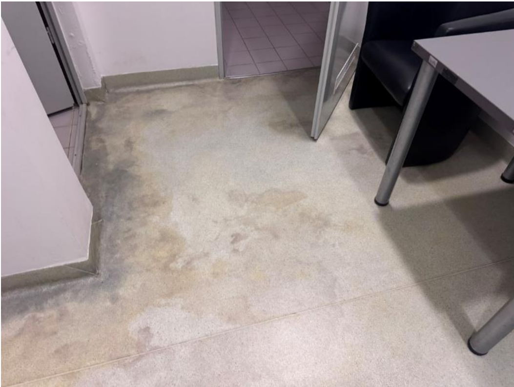
2.289 pav. Apgadinta grindų danga
