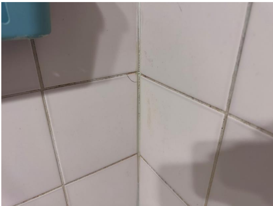
2.48 pav. Sutrūkusi plytelių apdaila
