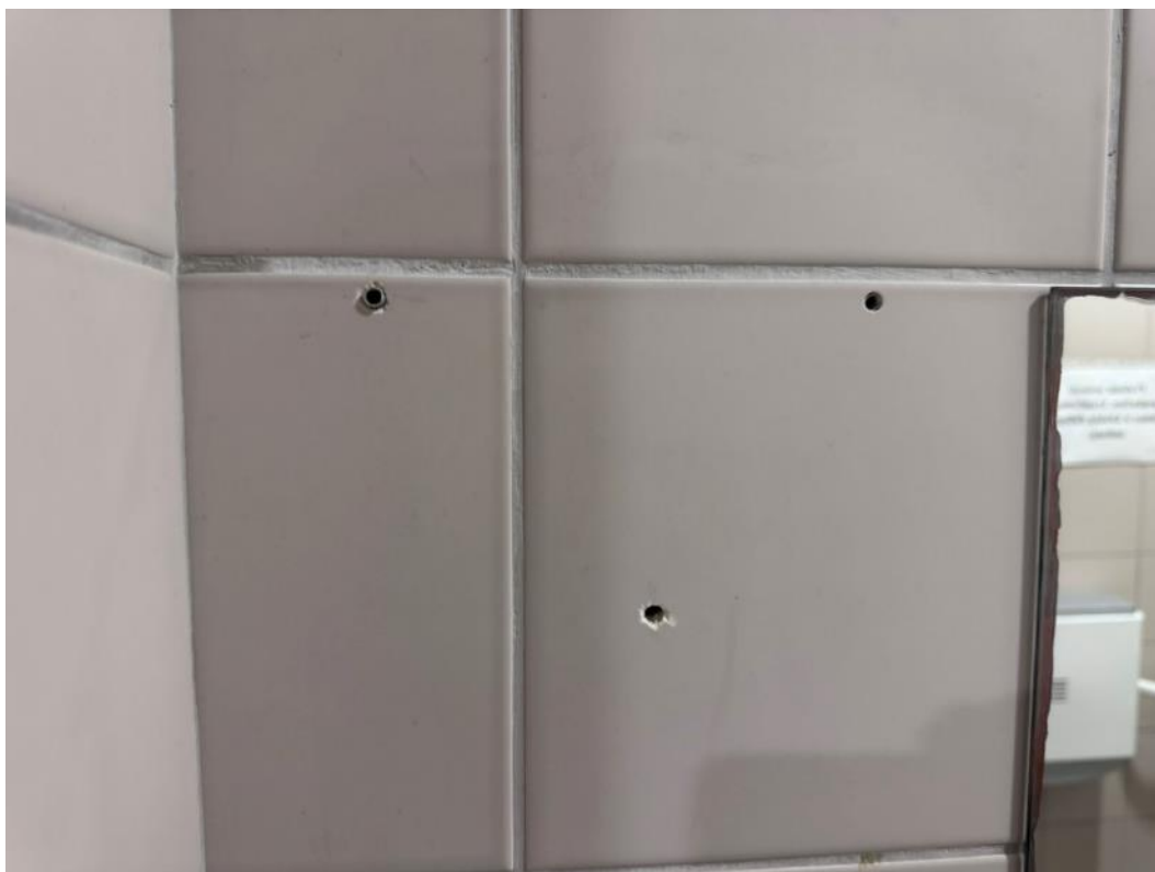
2.135 pav. Apgadinta plytelių apdaila
