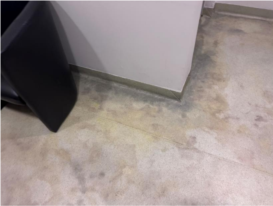
2.288 pav. Apgadinta grindų danga
