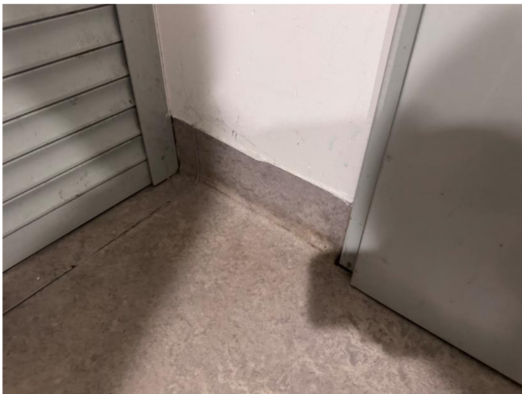
2.109 pav. Apgadintos grindjuostės
