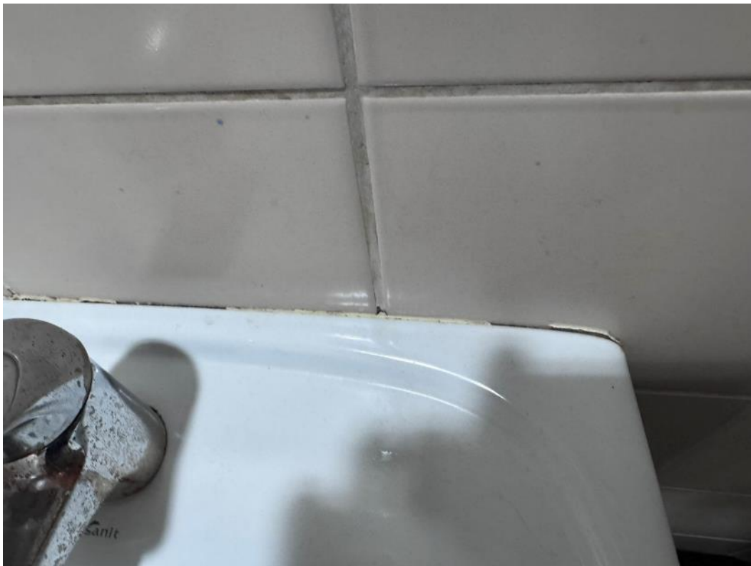
2.99 pav. Pažeistas hermetikas
