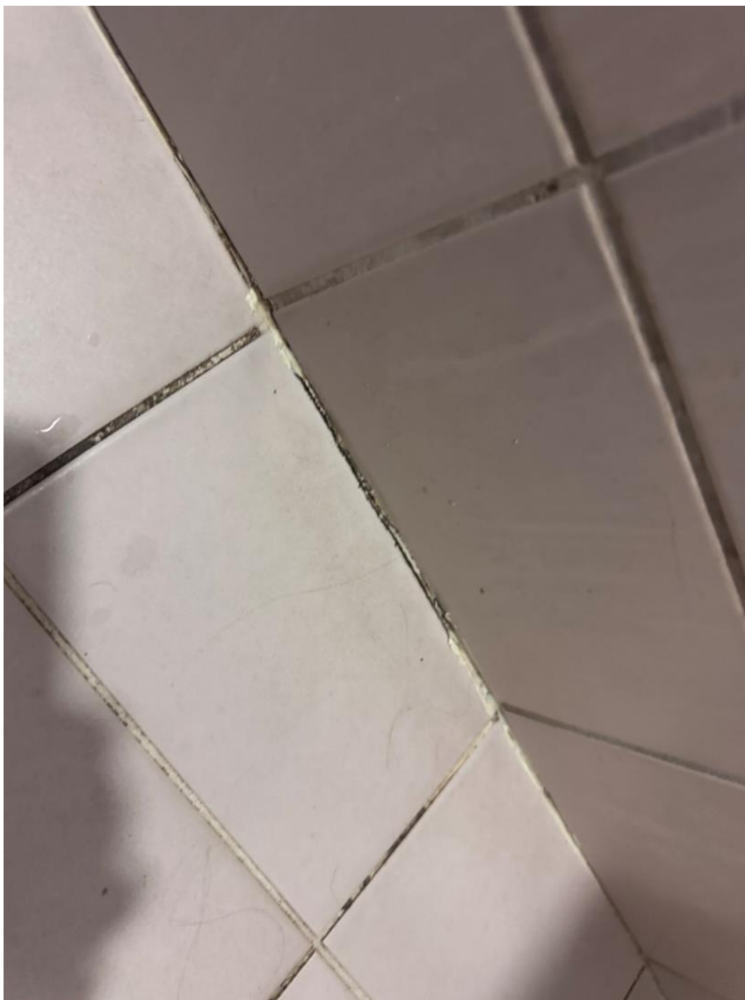
2.14 pav. Pažeistas hermetikas
