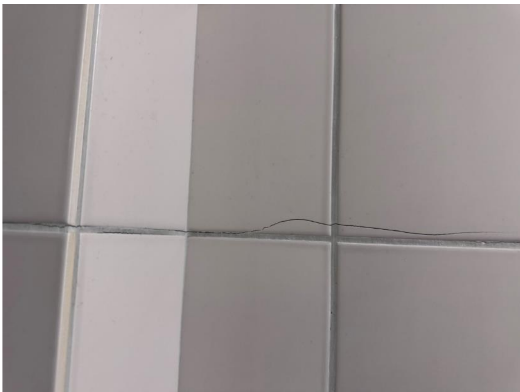
2.27 pav. Sutrūkusi plytelių apdaila
