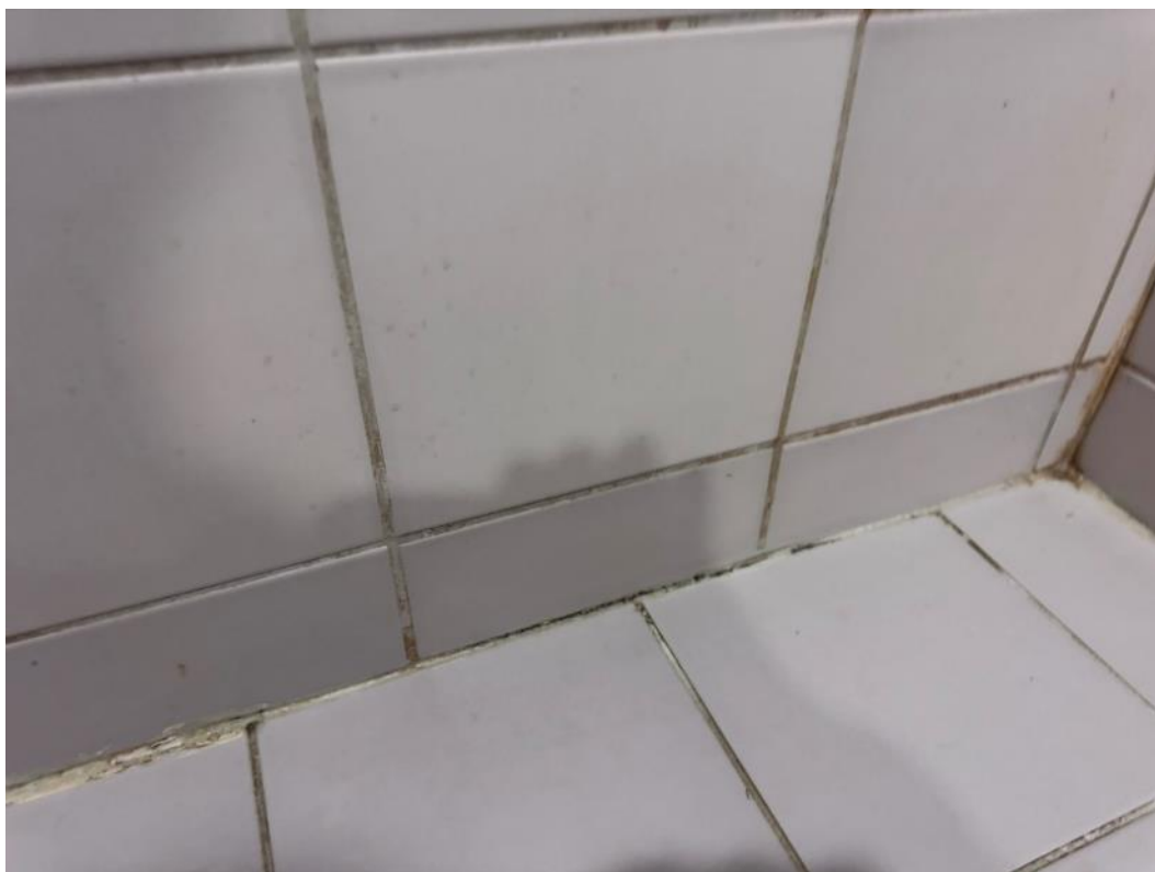
2.300 pav. Pažeistas hermetikas
