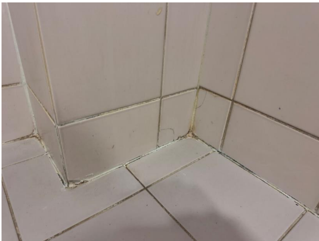
2.78 pav. Pažeistas hermetikas
