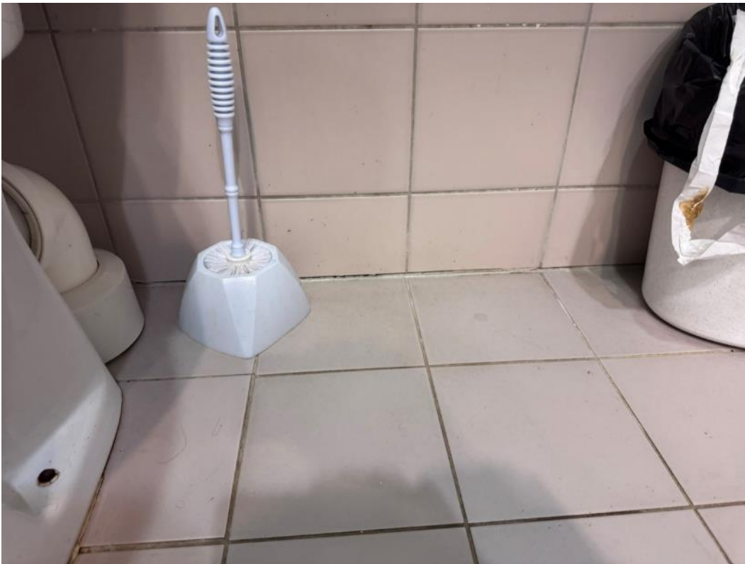
2.247 pav. Pažeistas hermetikas
