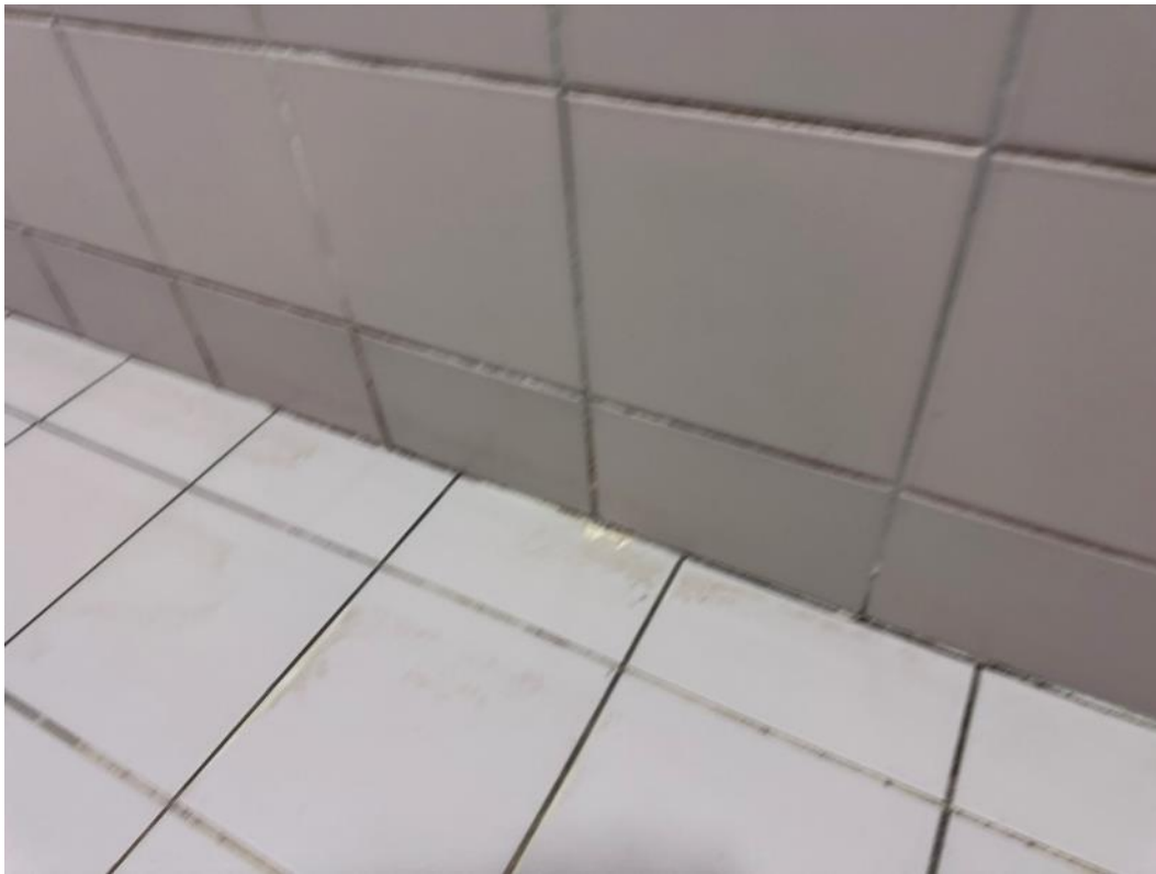
2.201 pav. Pažeistas hermetikas
