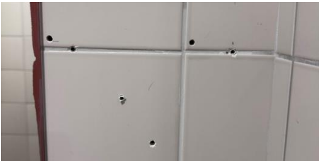
3.5pav. Pažeista plytelių apdaila
