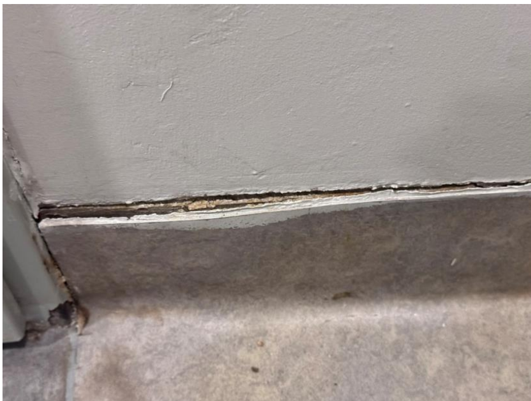
2.66 pav. Apgadintos grindjuostės
