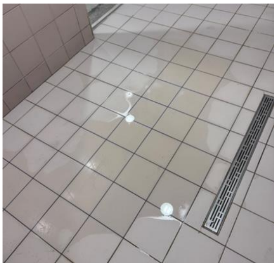
3.10 pav. Ant plytelių nusistovėjęs vanduo
