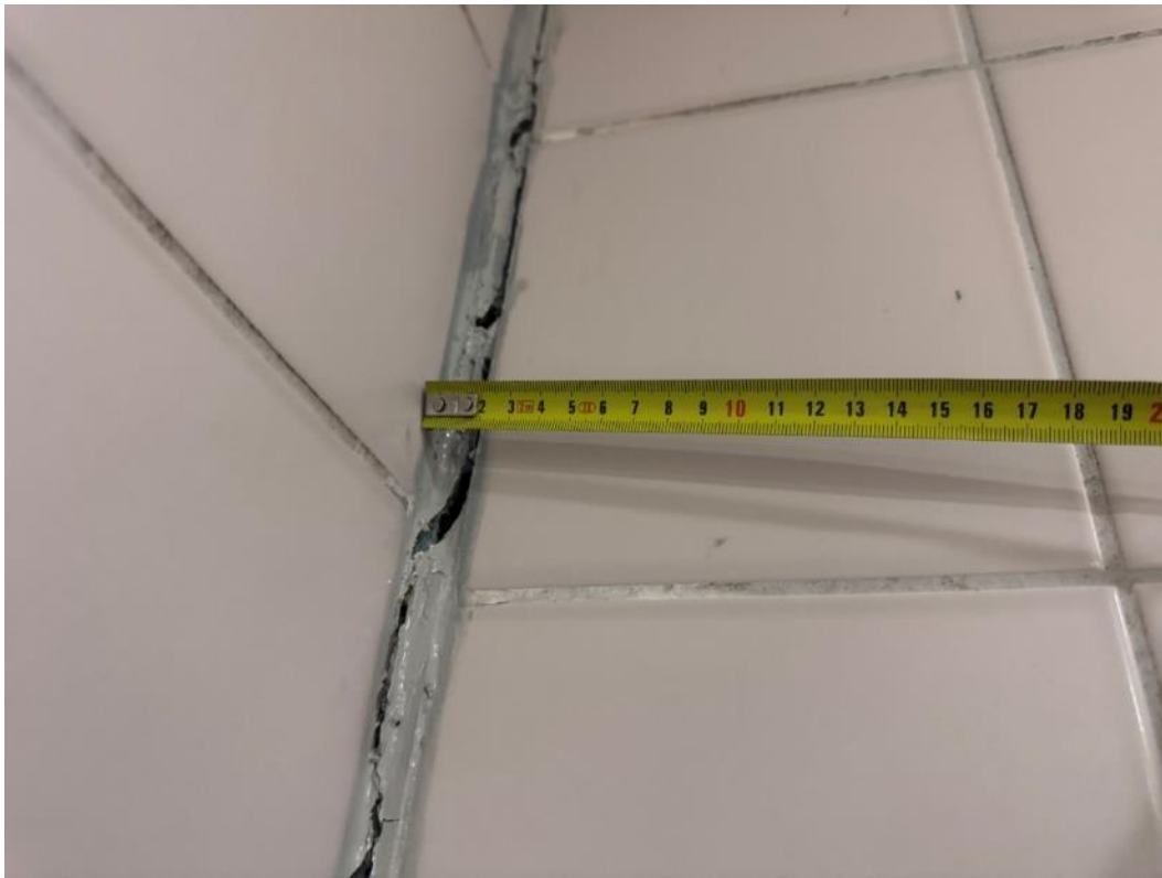
2.185 pav. Pažeistas hermetikas
