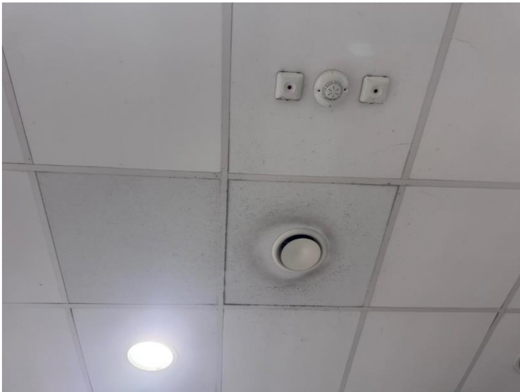
2.104 pav. Drėgmės pažeistos lubos
