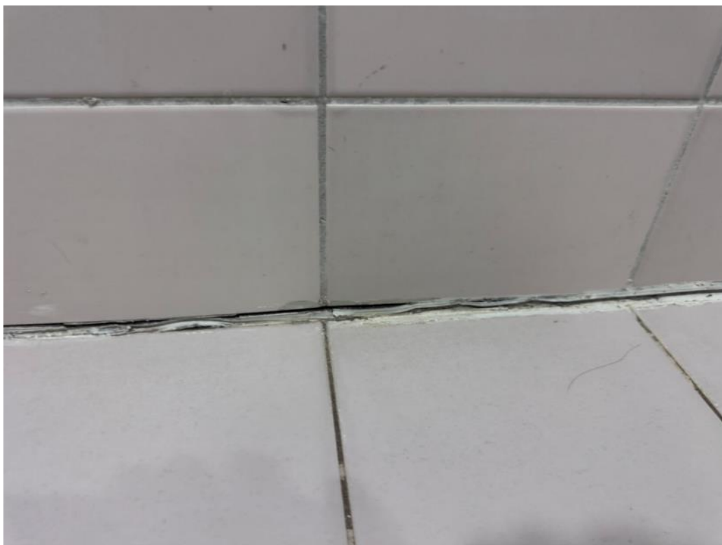
2.74 pav. Pažeistas hermetikas
