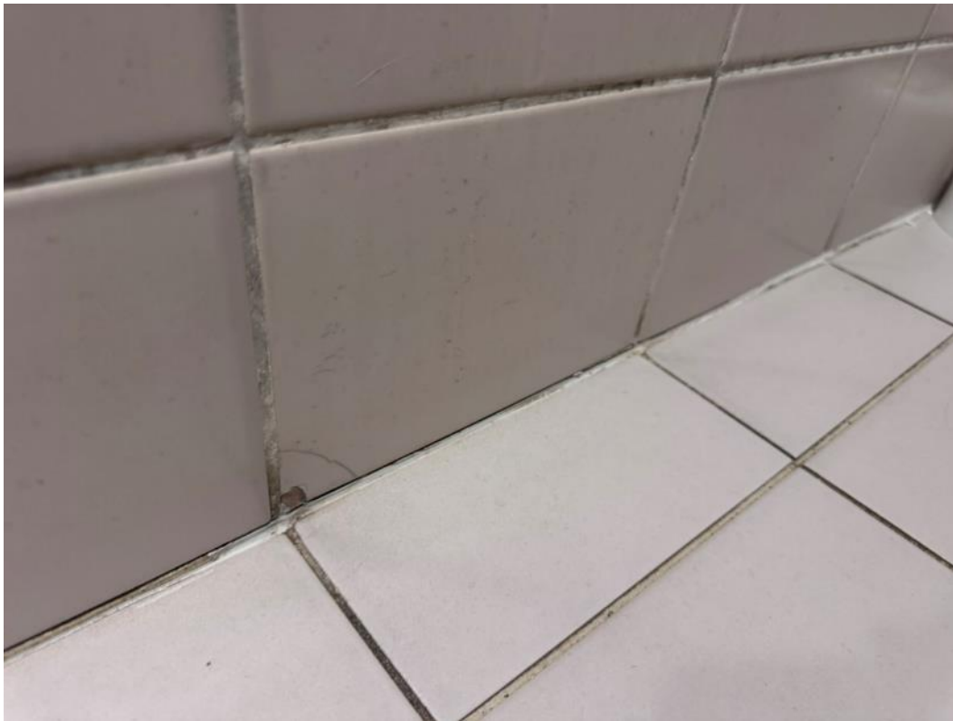
2.96 pav. Pažeistas hermetikas, sutrūkusi plytelių apdaila
