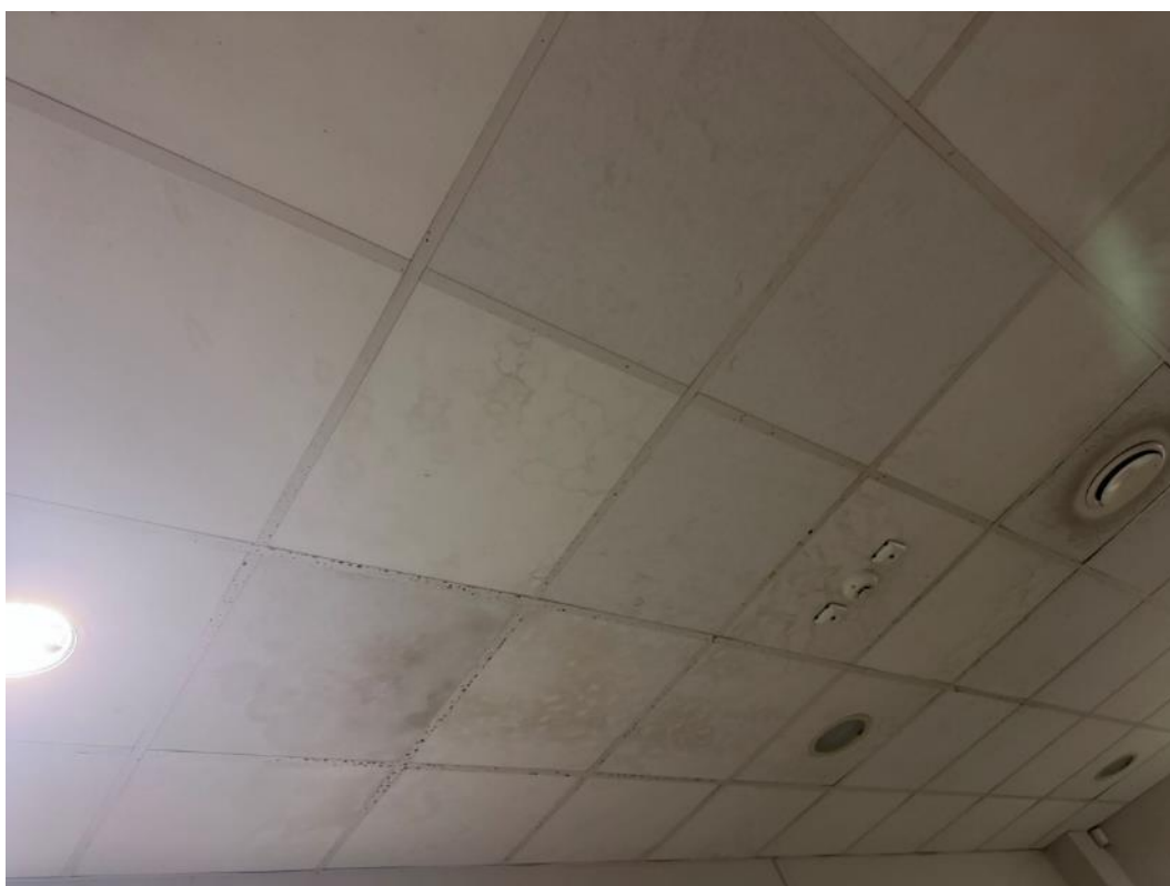
2.4 pav. Drėgmės pažeistos lubos
