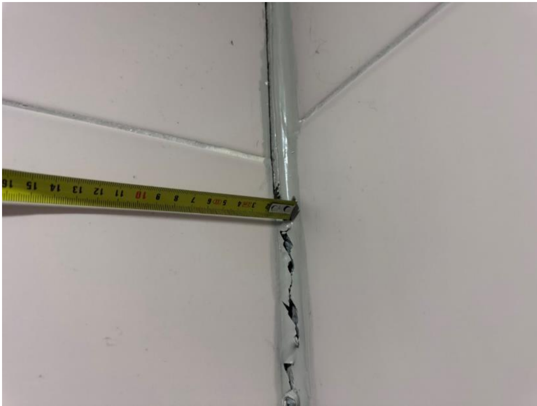
2.221 pav. Pažeistas hermetikas
