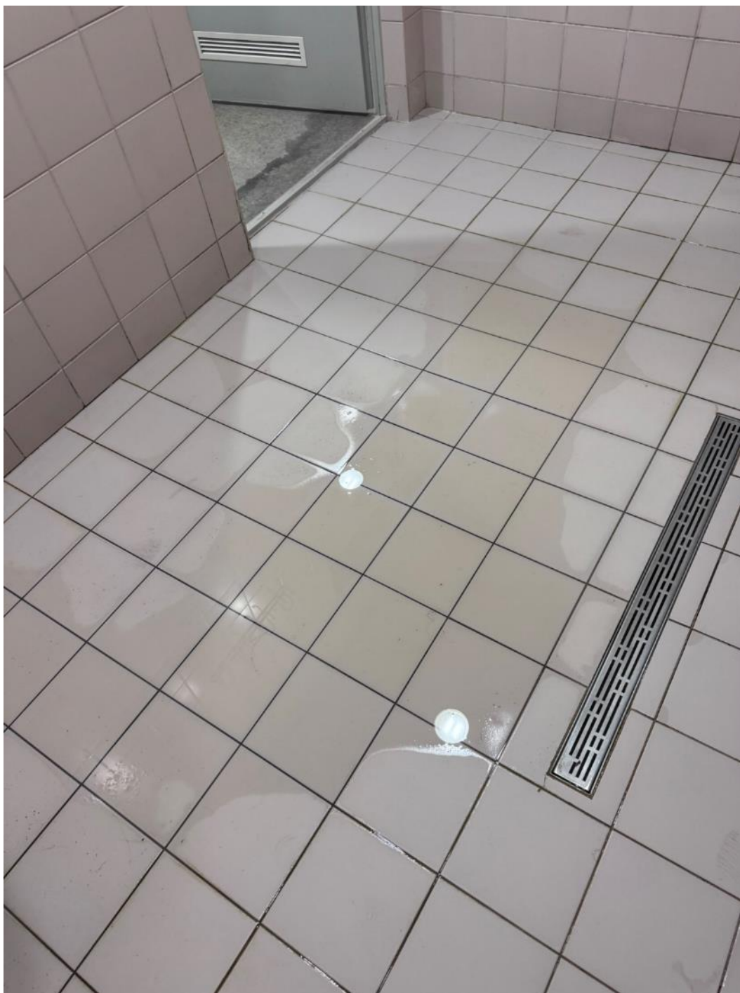
2.144 pav. Ant grindų nusistovėjęs vanduo
