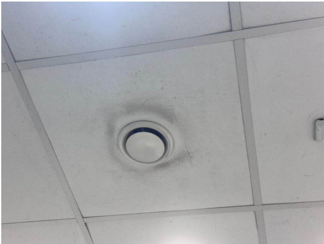
2.230 pav. Drėgmės pažeistos lubos
