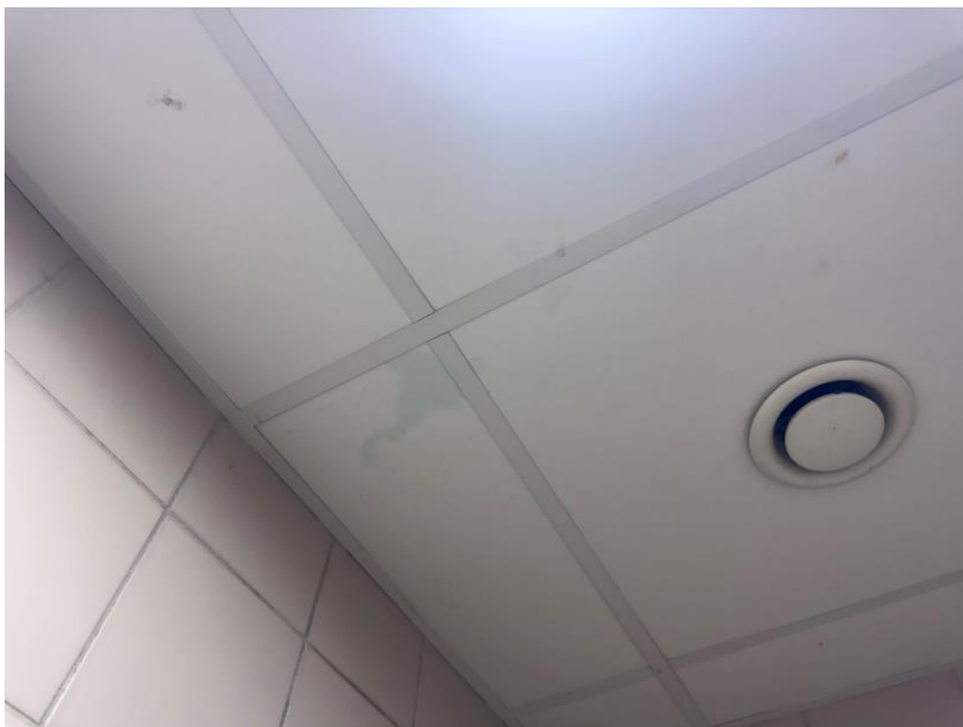
2.263 pav. Drėgmės pažeistos lubos
