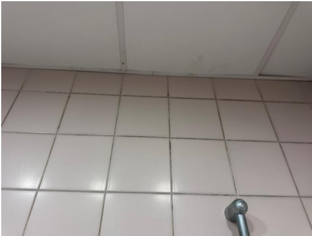
2.152 pav. Drėgmės pažeistos lubos
