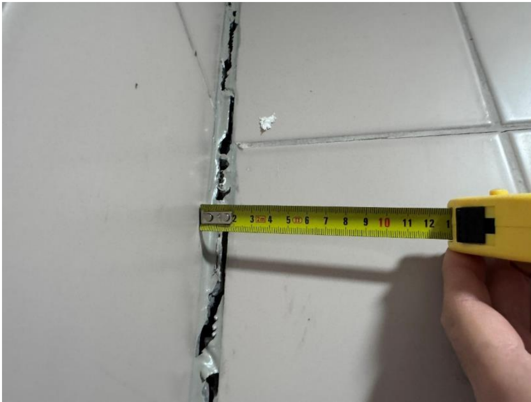
2.213 pav. Pažeistas hermetikas
