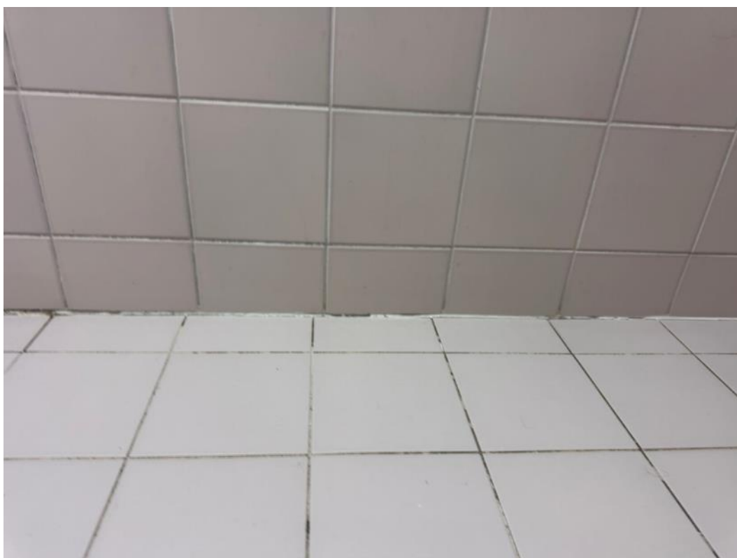
2.81 pav. Pažeistas hermetikas
