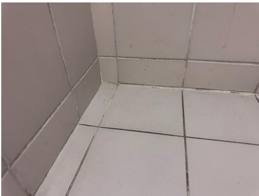
2.309 pav. Pažeistas hermetikas
