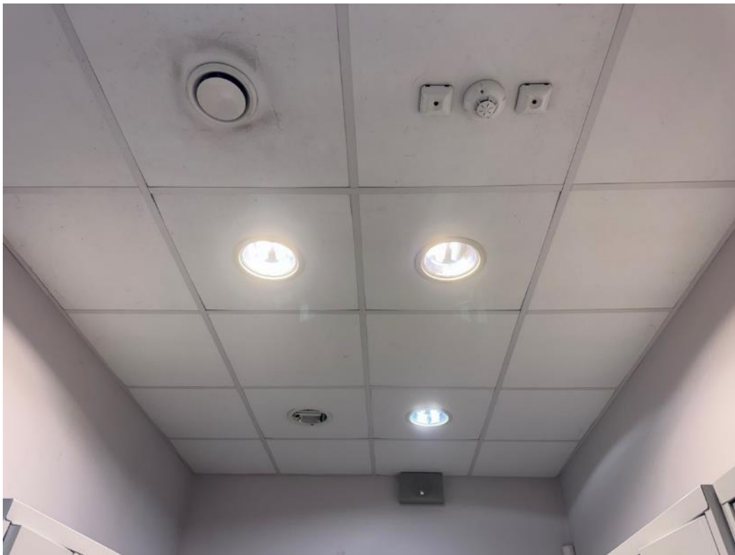
2.228 pav. Drėgmės pažeistos lubos
