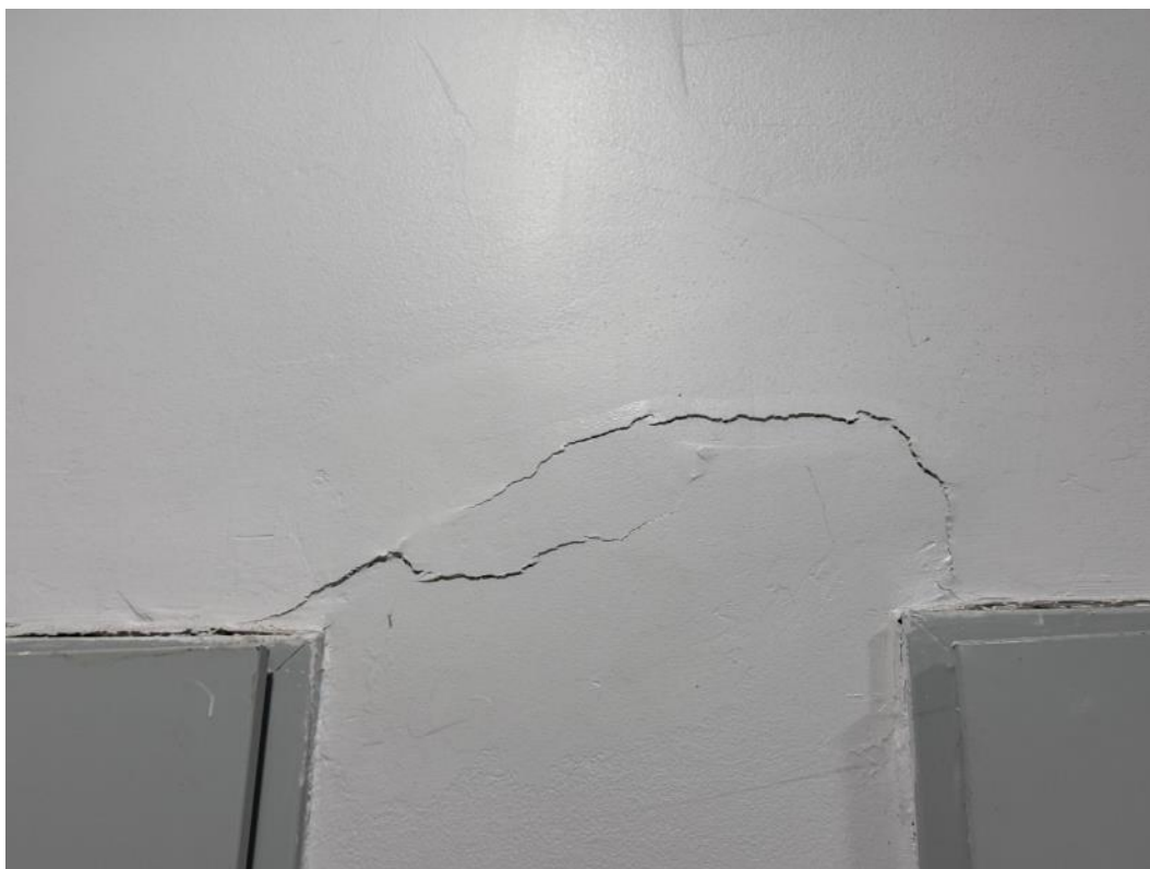
2.113 pav. Sutrūkusi sienos apdaila
