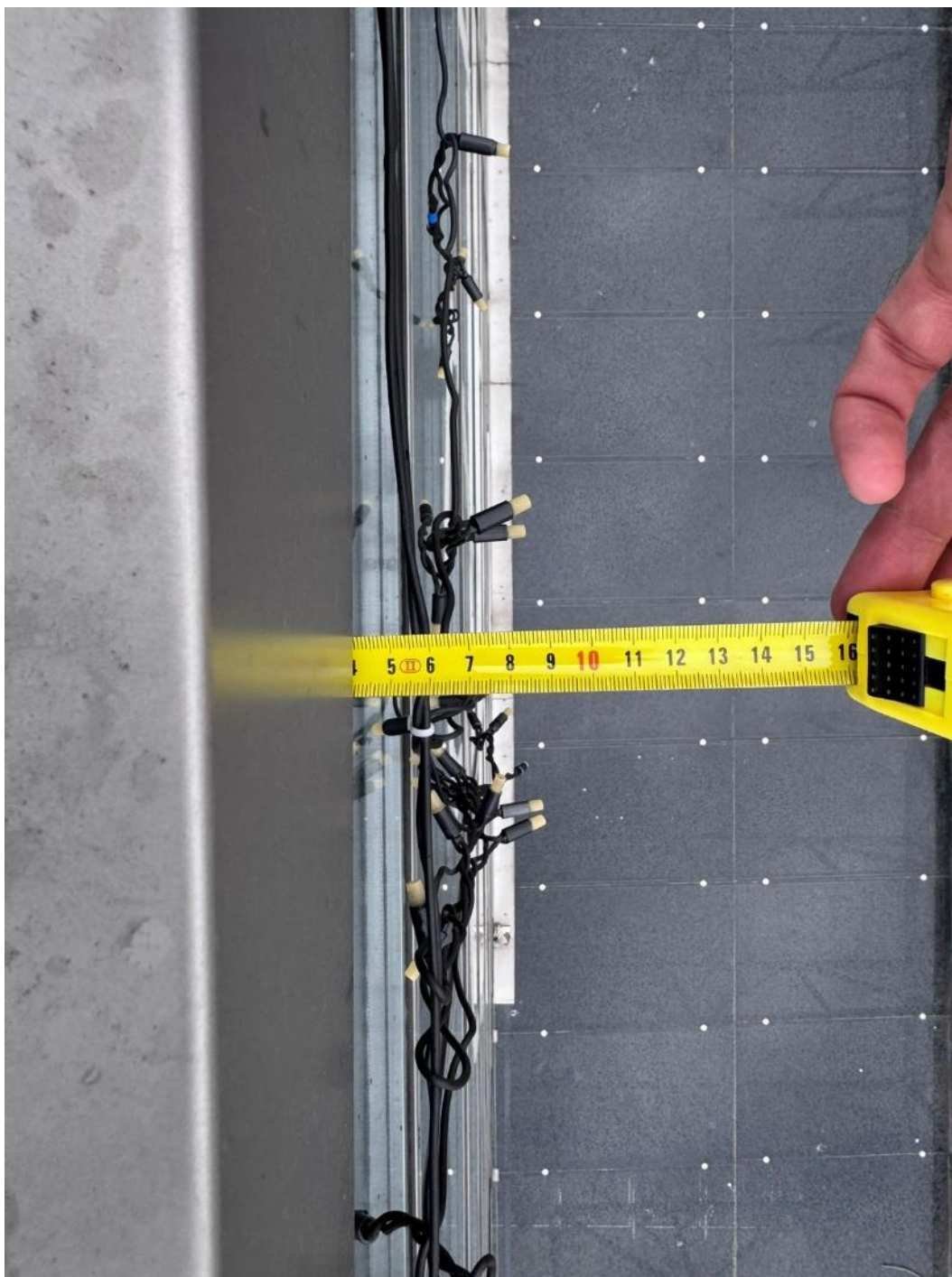
2.369 pav. Apskardinimo išsikišimas (~4,1cm)
