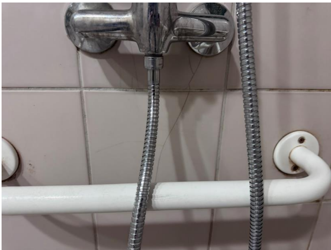
2.46 pav. Sutrūkusi plytelių apdaila
