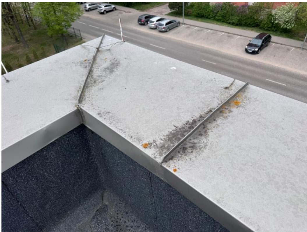
2.319 pav. Drėgmės paveikta parapeto skarda
