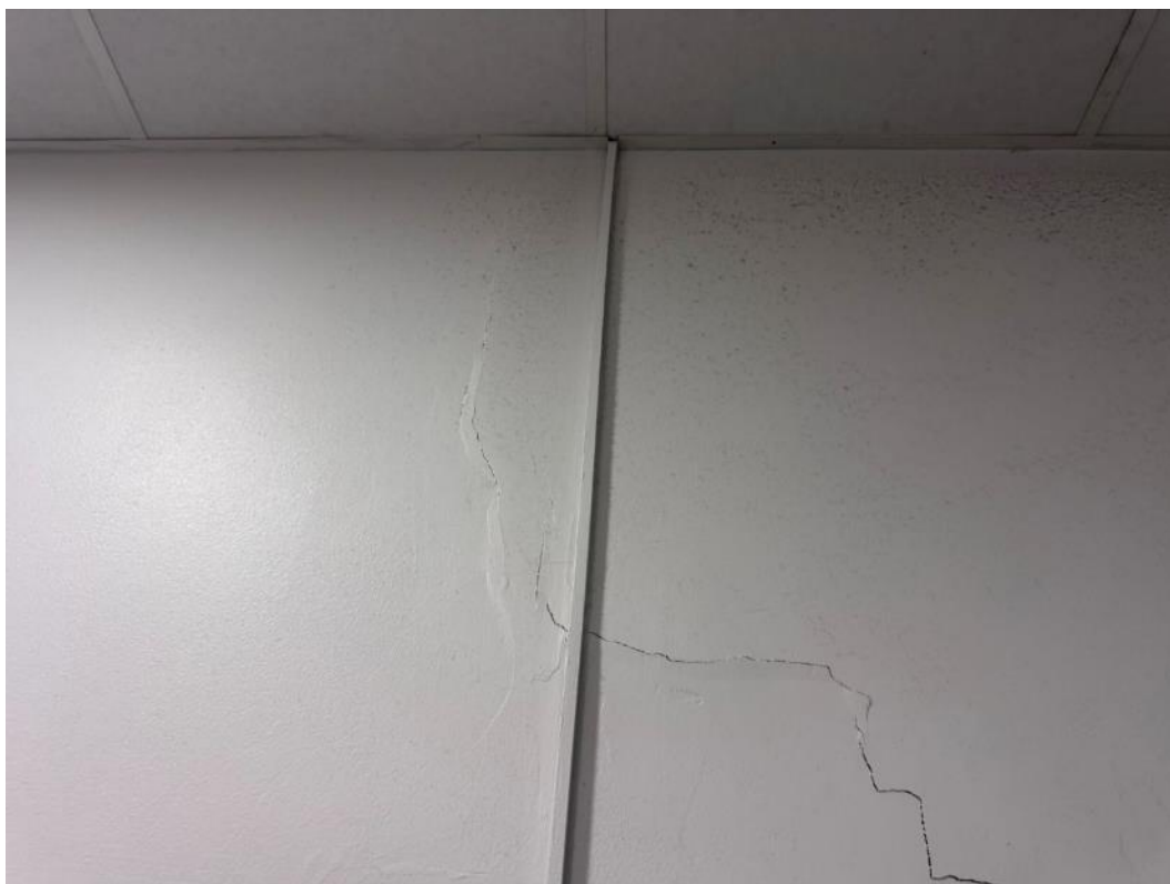
2.165 pav. Sutrūkusi sienos apdaila
