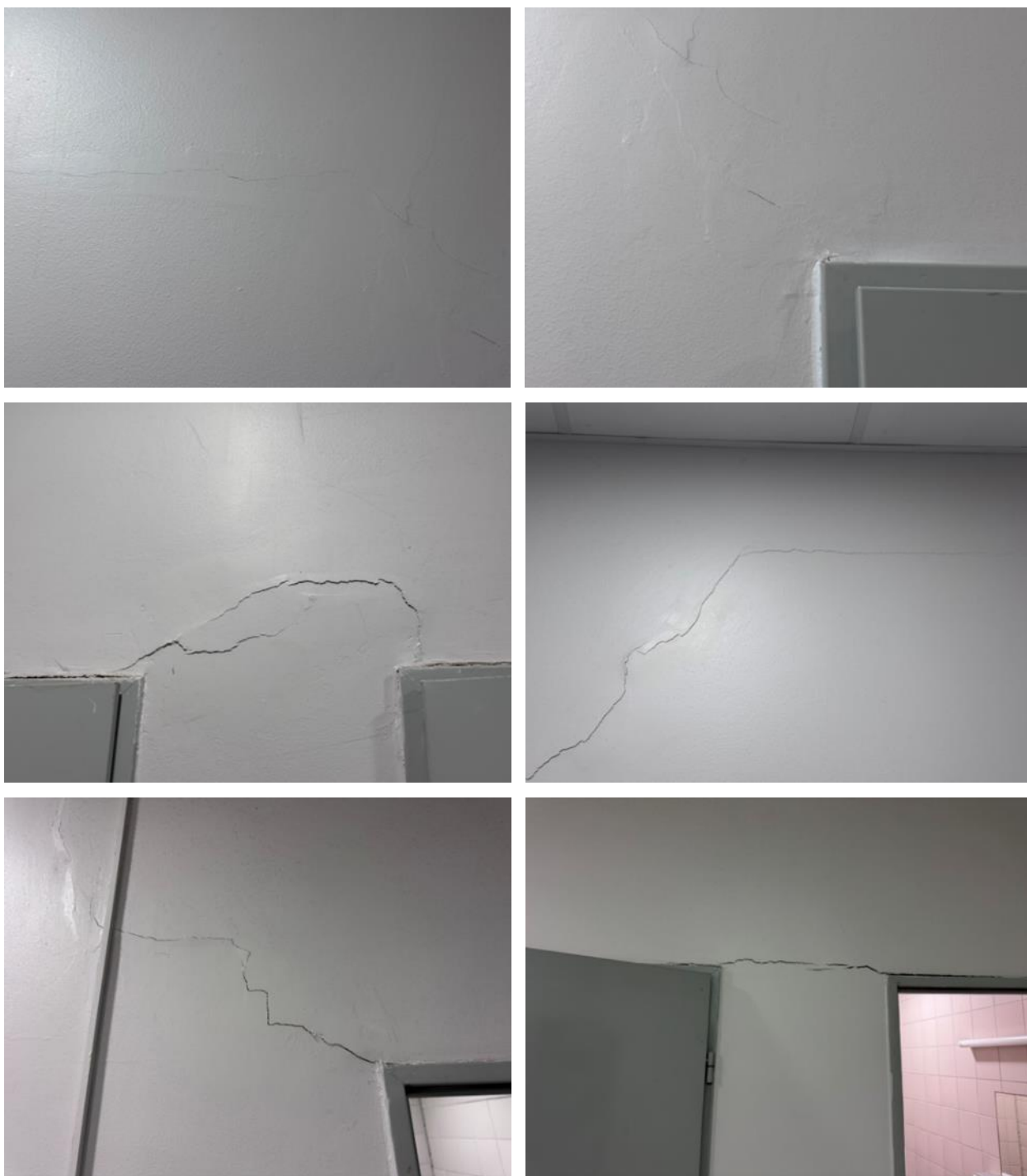
3.7 pav. Sutrūkusi sienų apdaila
