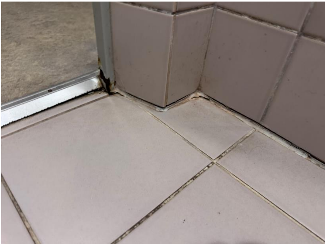
2.93 pav. Pažeistas hermetikas
