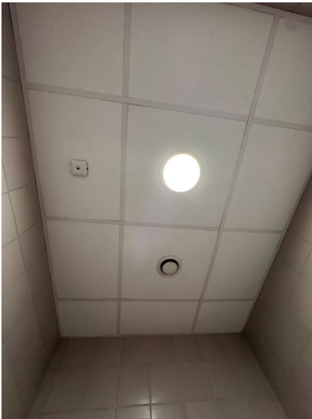
2.307 pav. Drėgmės pažeistos lubos
