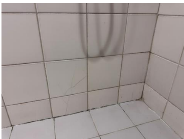
3.4 pav. Pažeista plytelių apdaila
