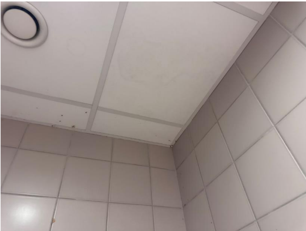
2.240 pav. Drėgmės pažeistos lubos
