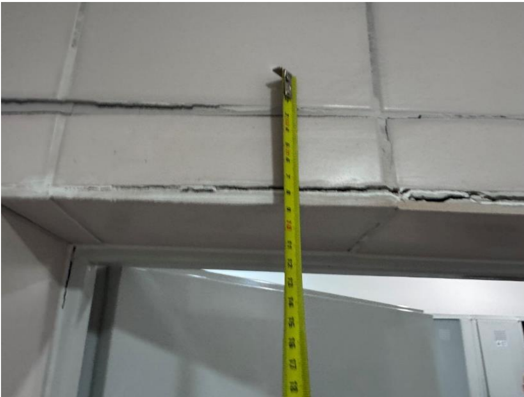
2.217 pav. Apgadinta plytelių apdaila
