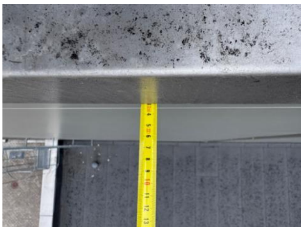
3.18 pav. Nepakankamas parapetų skardos iškišimas
