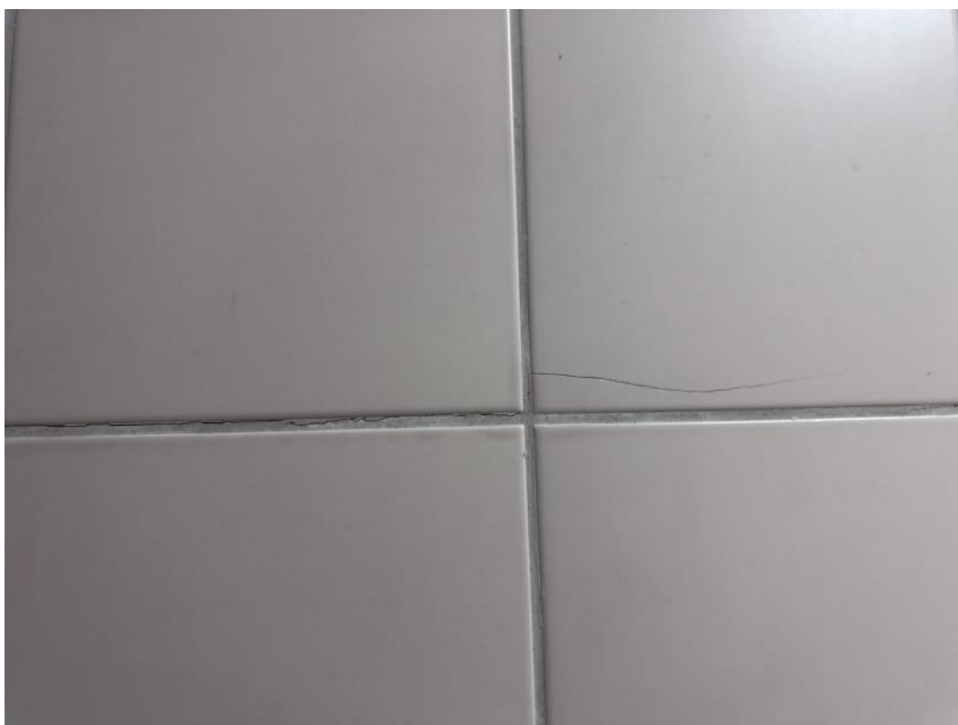
2.28 pav. Sutrūkusi plytelių apdaila
