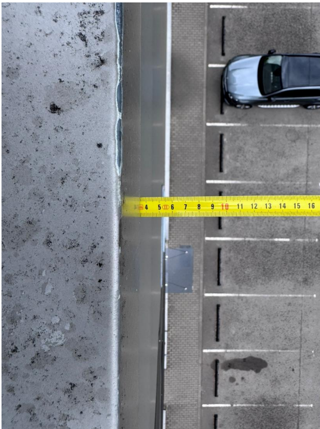
2.341 pav. Apskardinimo išsikišimas (~3,6cm)
