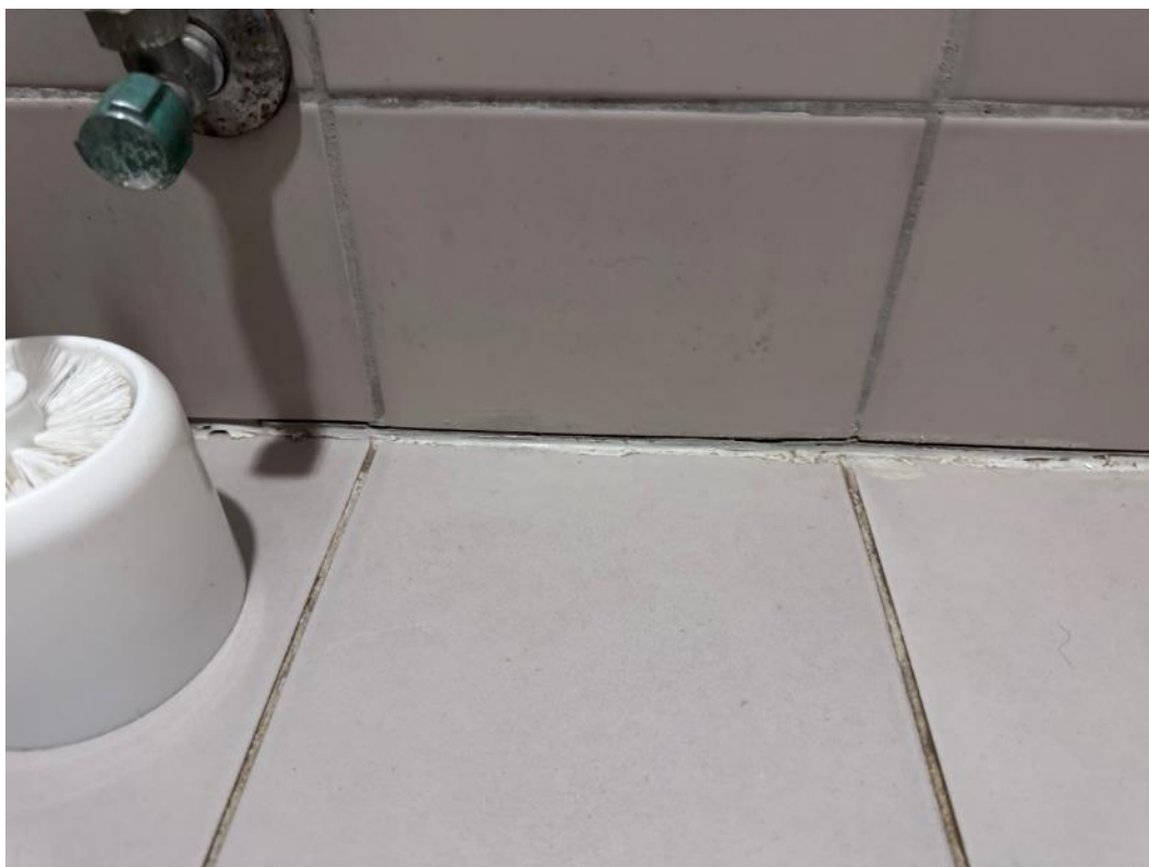
2.21 pav. Pažeistas hermetikas
