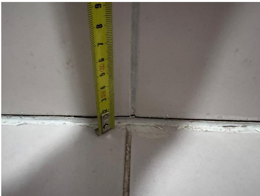
2.23 pav. Pažeistas hermetikas
