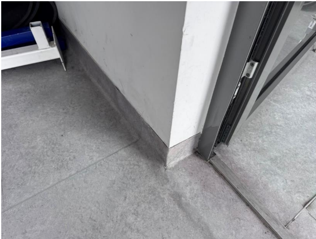
2.278 pav. Apgadintos grindjuostės
