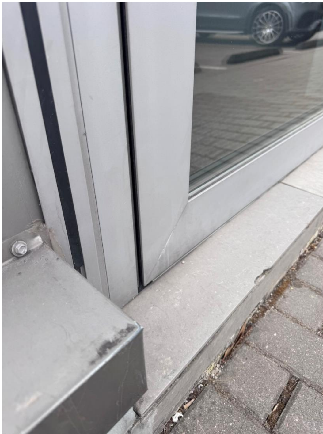
2.374 pav. Deformuotos durys
