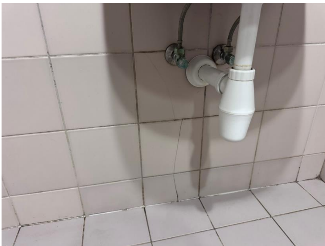
2.43 pav. Sutrūkusi plytelių apdaila
