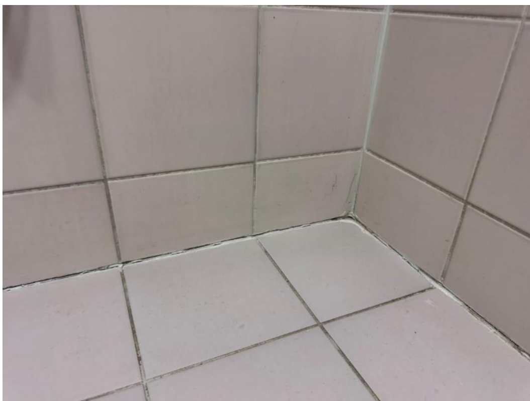
2.77 pav. Pažeistas hermetikas
