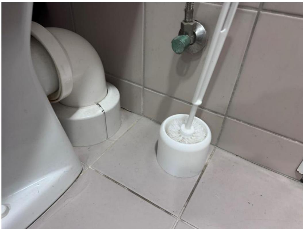
2.310 pav. Pažeistas hermetikas
