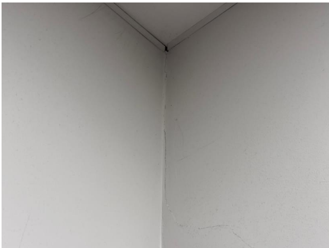
2.115 pav. Sutrūkusi sienos apdaila
