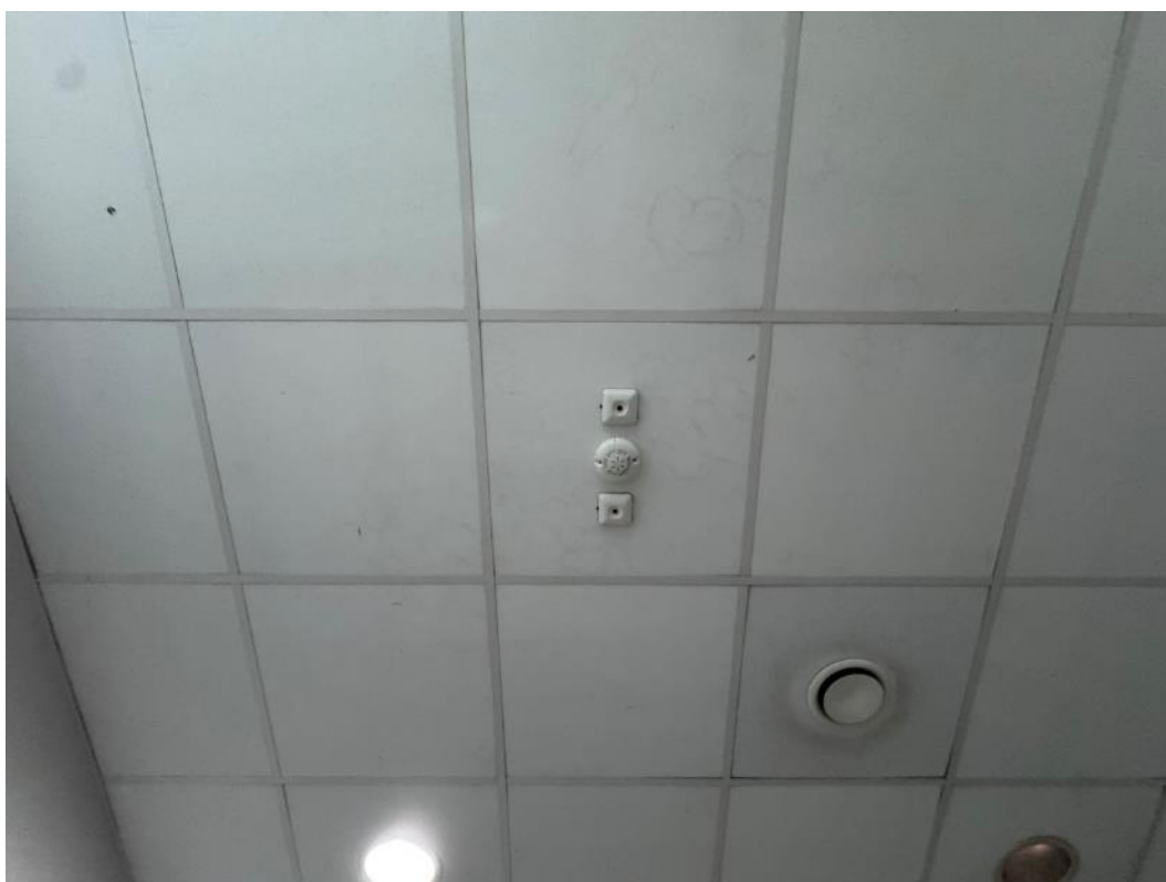
2.53 pav. Drėgmės pažeistos lubos
