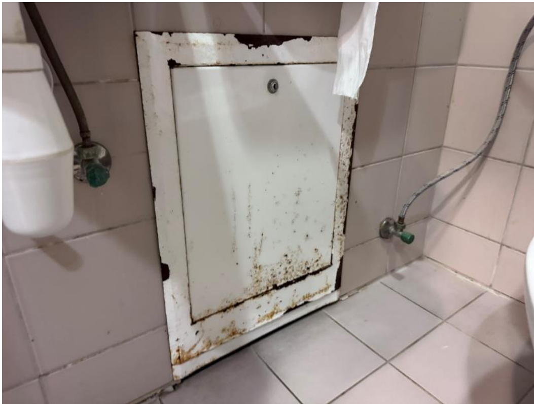
2.245 pav. Korozijos paveiktos durys
