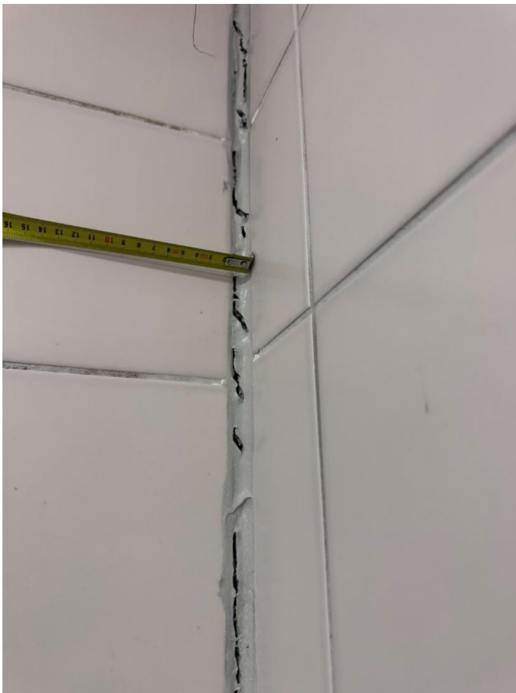
2.154 pav. Pažeistas hermetikas
