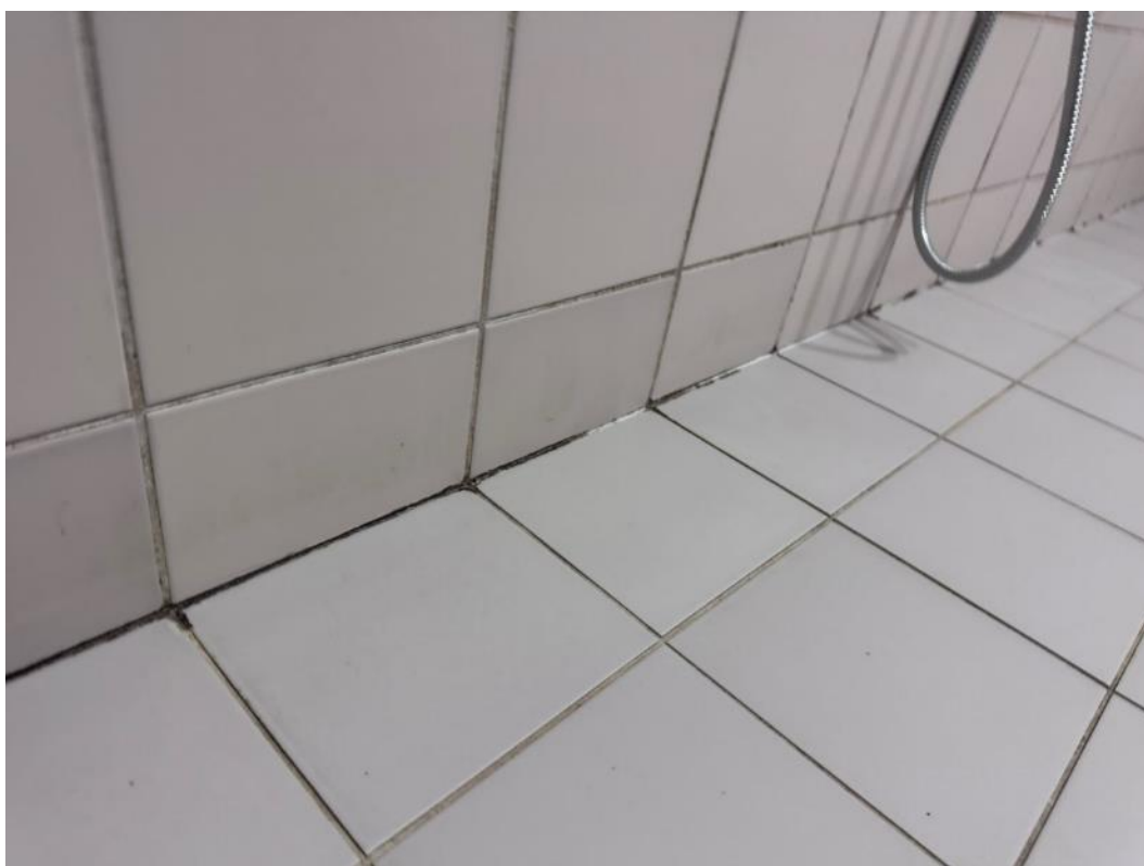
2.39 pav. Pažeistas hermetikas
