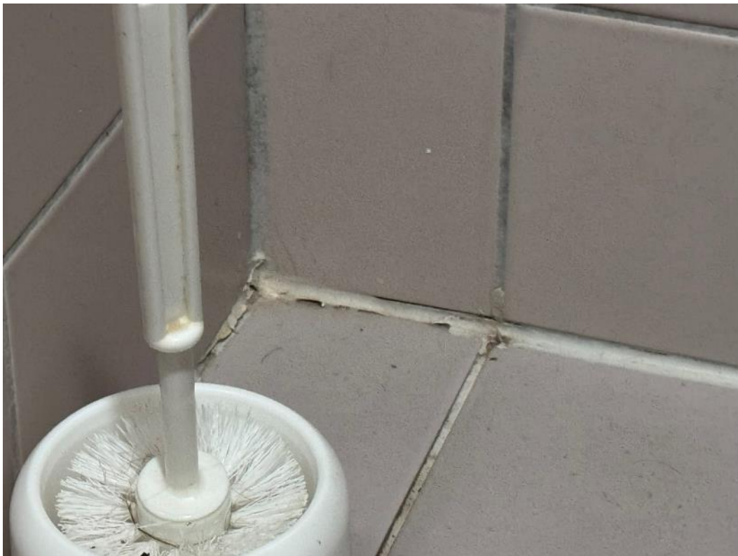
2.97 pav. Pažeistas hermetikas
