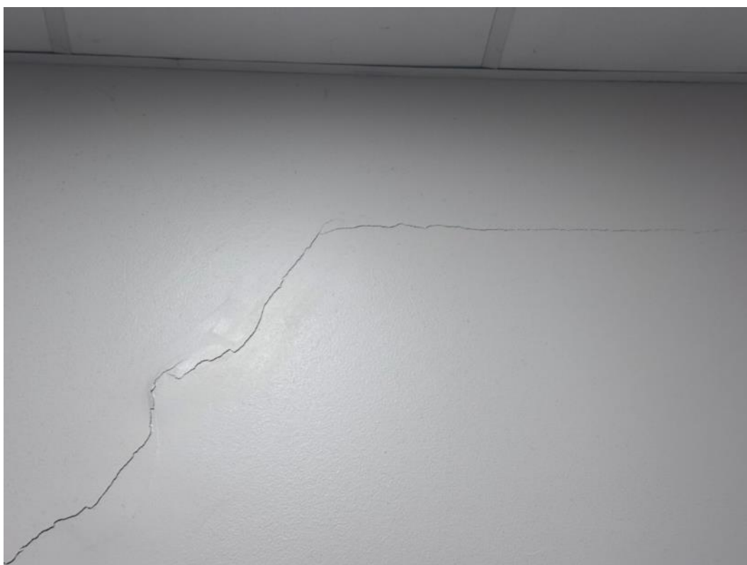
2.112 pav. Sutrūkusi sienos apdaila
