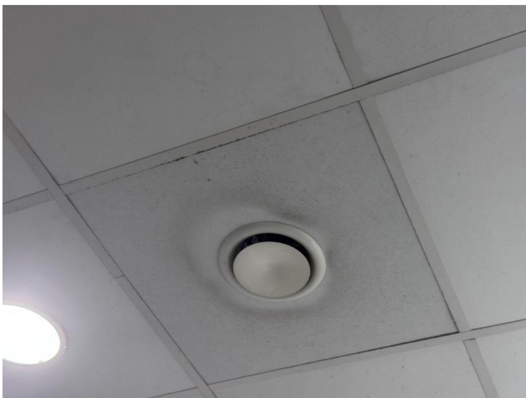
2.57 pav. Drėgmės pažeistos lubos
