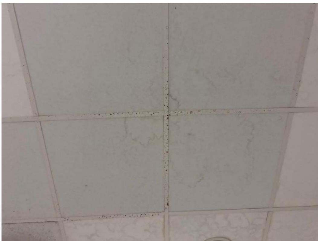
2.9 pav. Drėgmės pažeistos lubos
