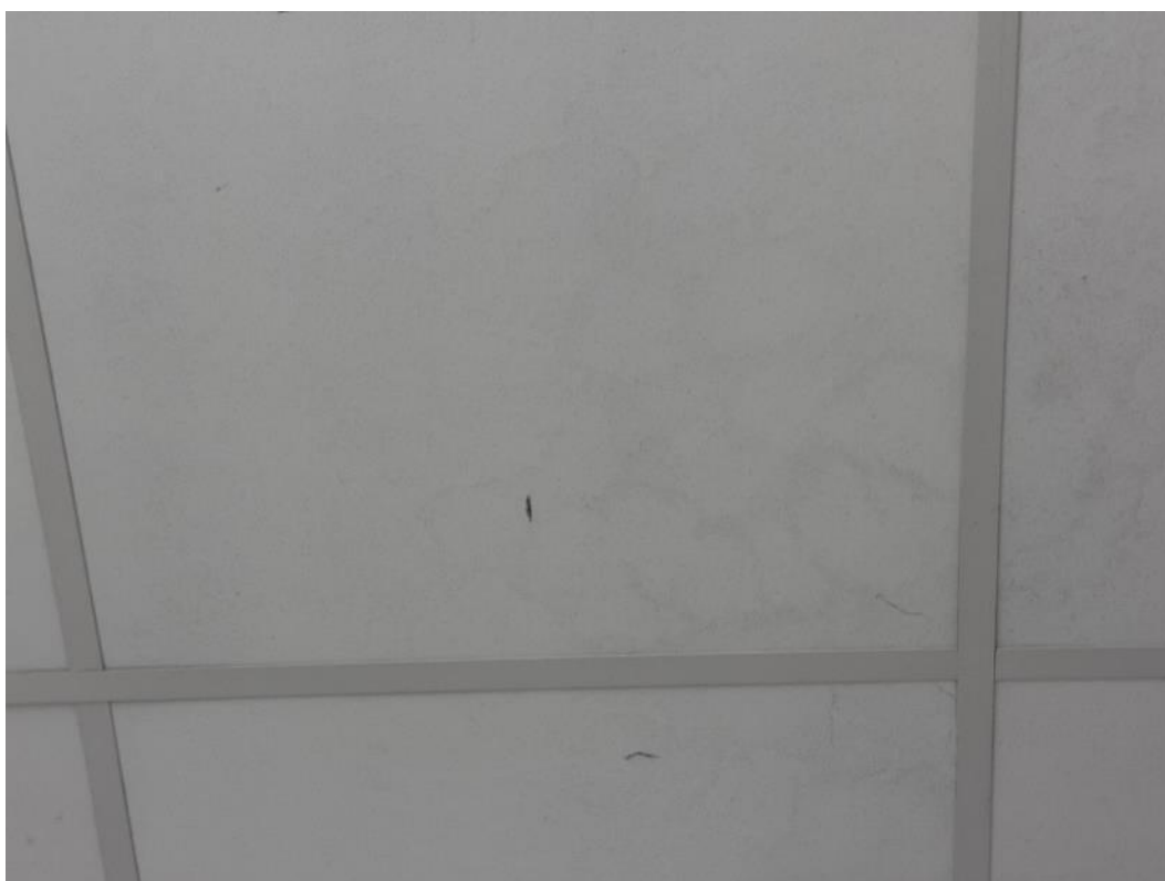
2.55 pav. Drėgmės pažeistos lubos
