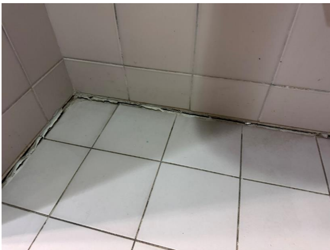
2.242 pav. Pažeistas hermetikas
