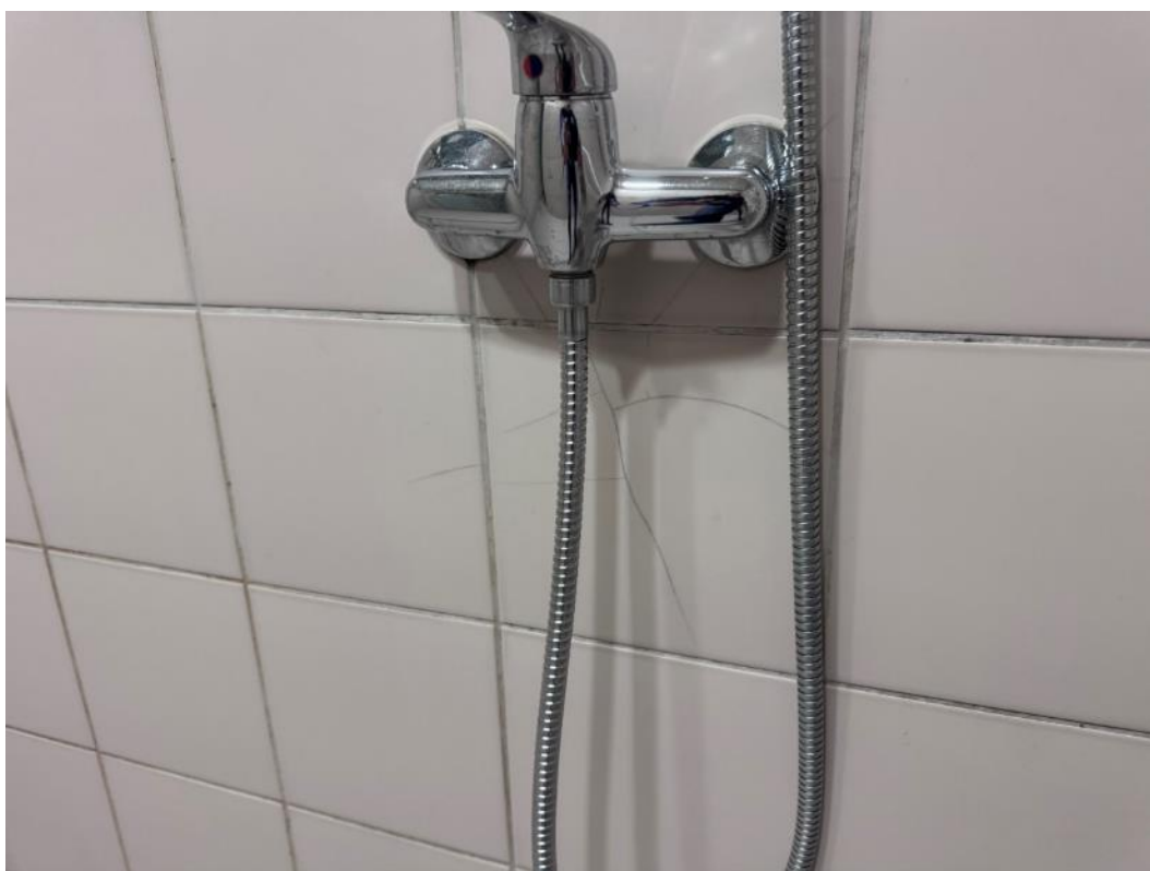
2.47 pav. Sutrūkusi plytelių apdaila
