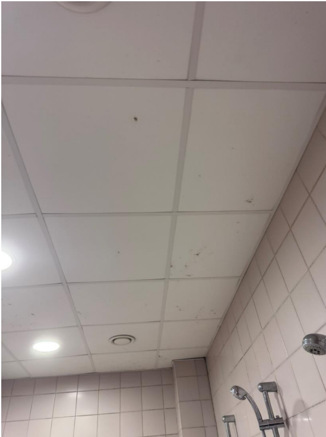
2.190 pav. Drėgmės pažeistos lubos
