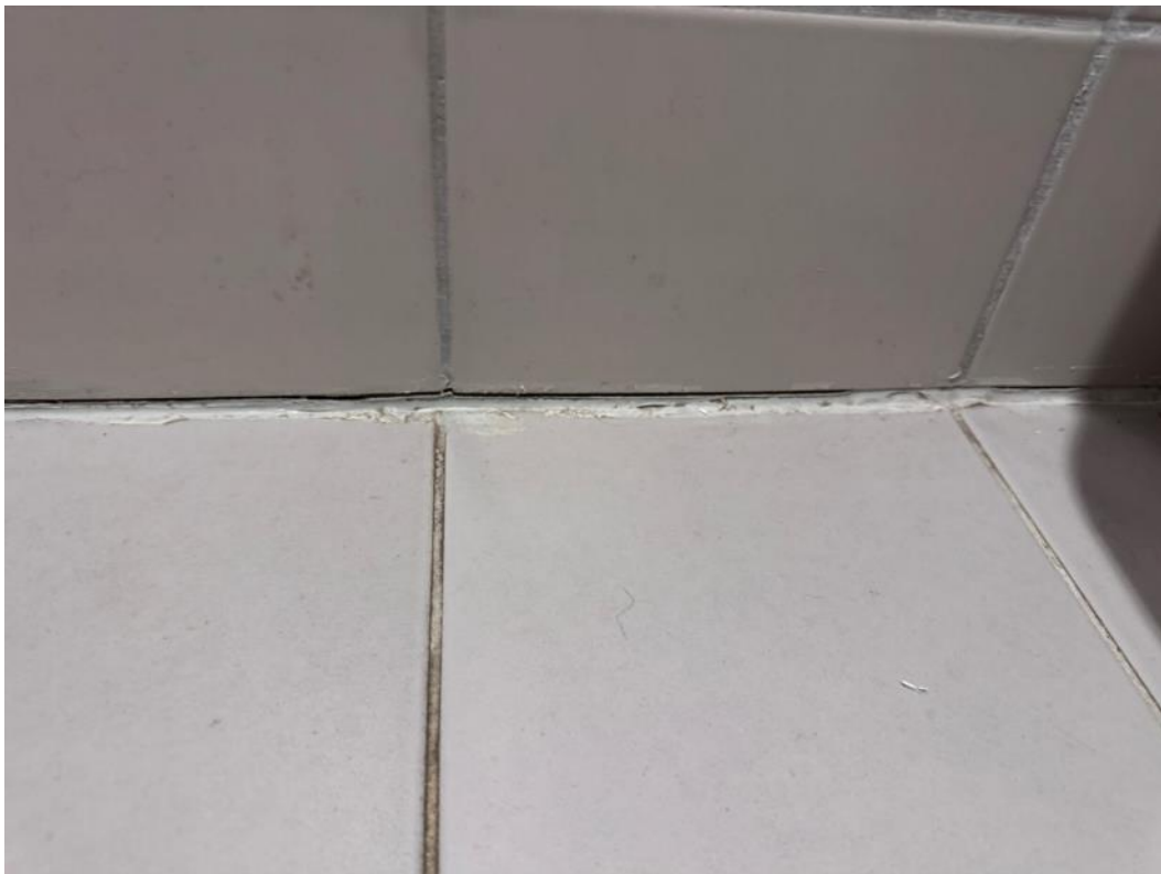
2.20 pav. Pažeistas hermetikas
