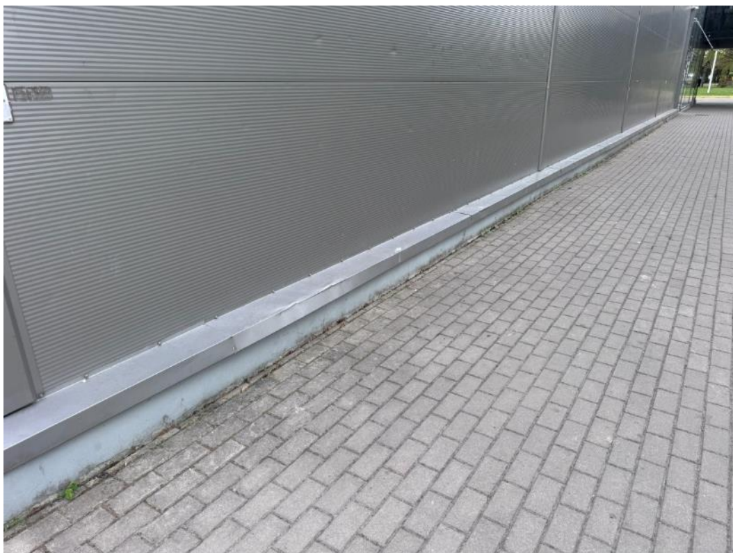
2.383 pav. Deformuotas apskardinimas
