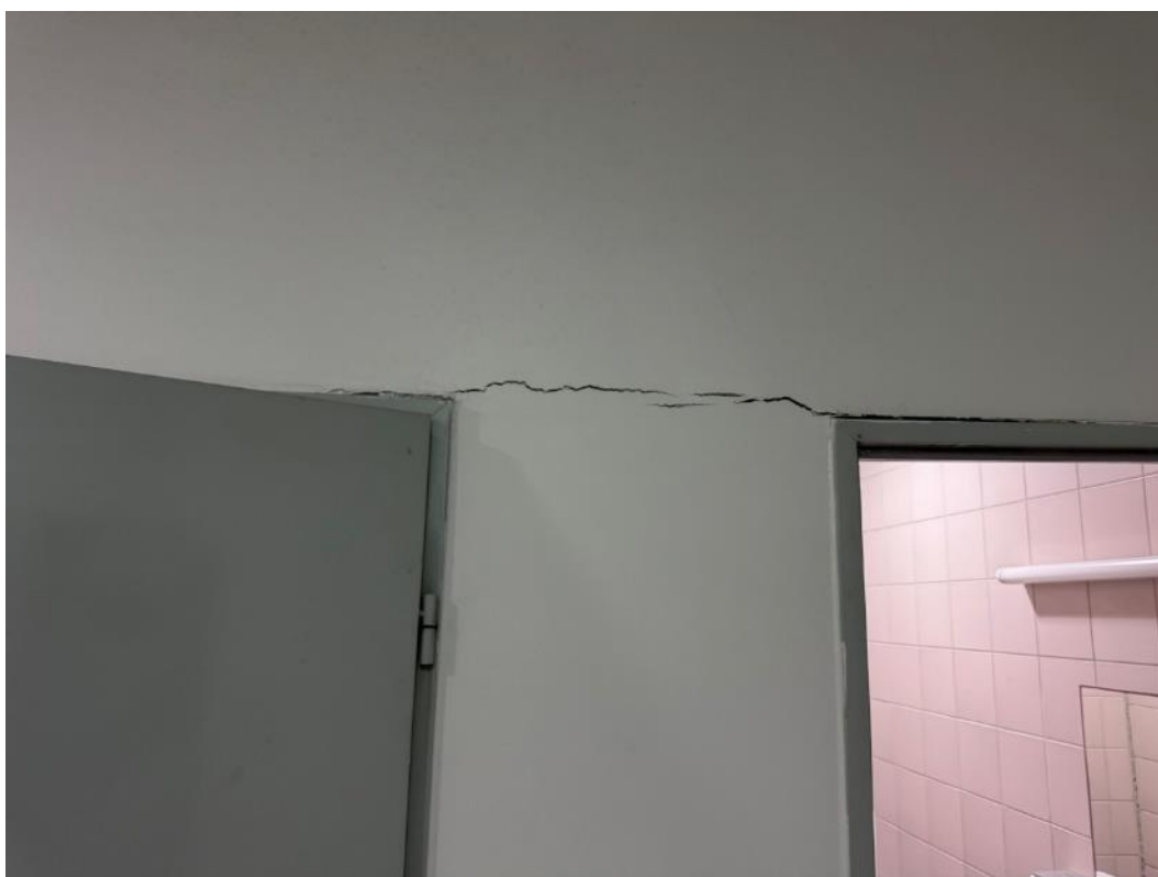
2.166 pav. Sutrūkusi sienos apdaila
