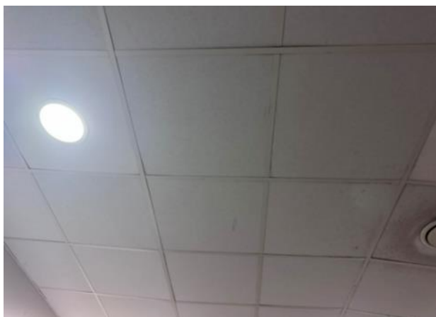
3.3 pav. Drėgmės pažeistos lubos
