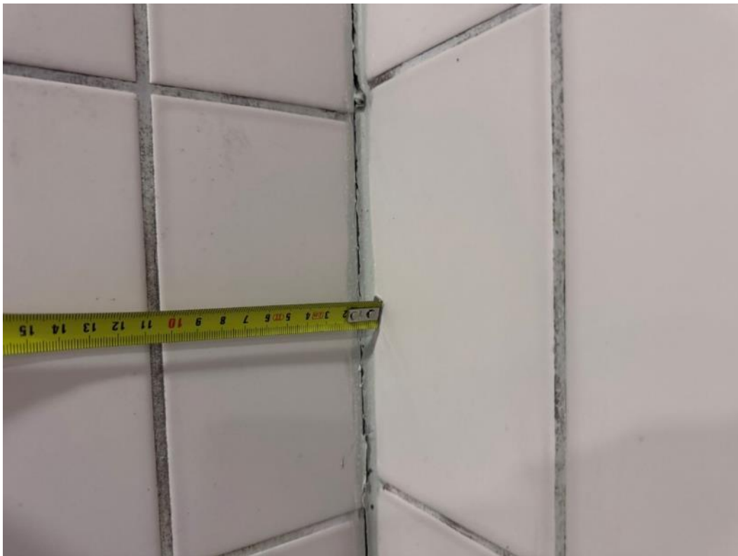
2.196 pav. Pažeistas hermetikas
