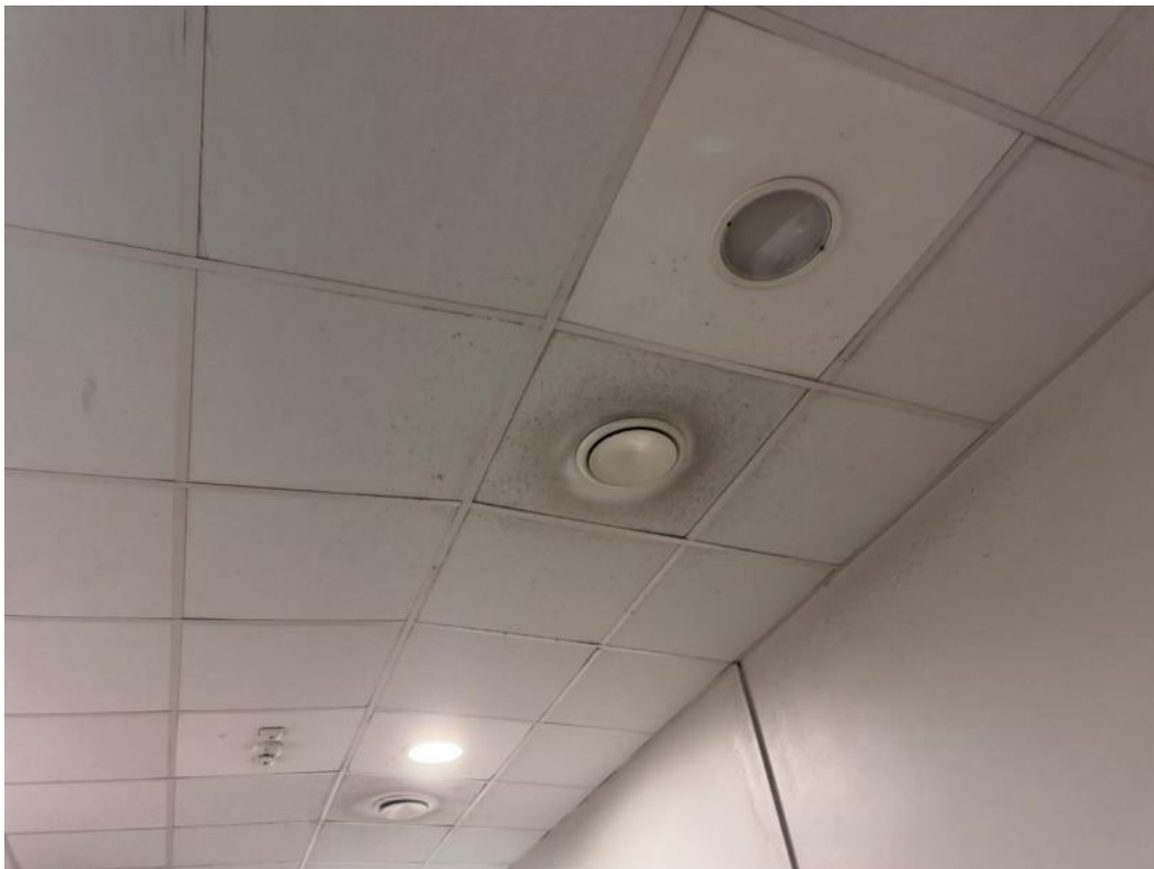
2.170 pav. Drėgmės pažeistos lubos
