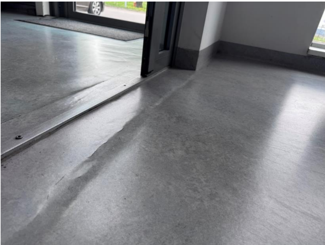
2.277 pav. Apgadinta grindų danga
