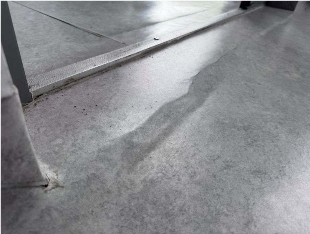
2.276 pav. Apgadinta grindų danga
