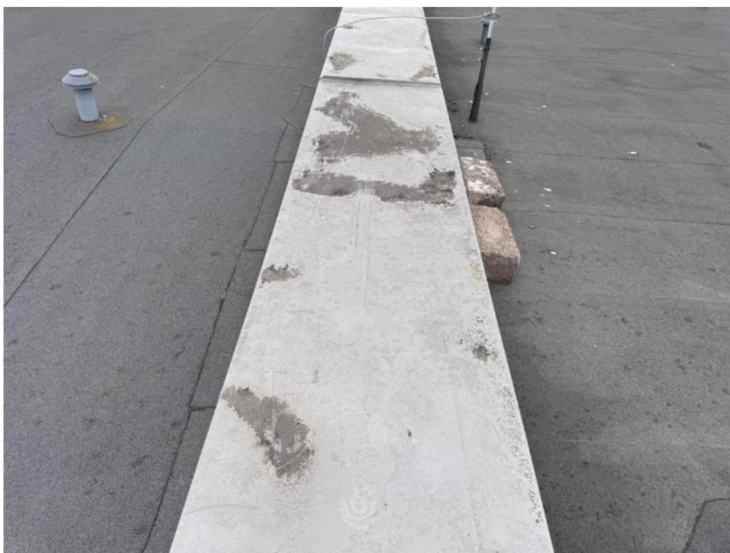
2.361 pav. Apgadintas apskardinimas
