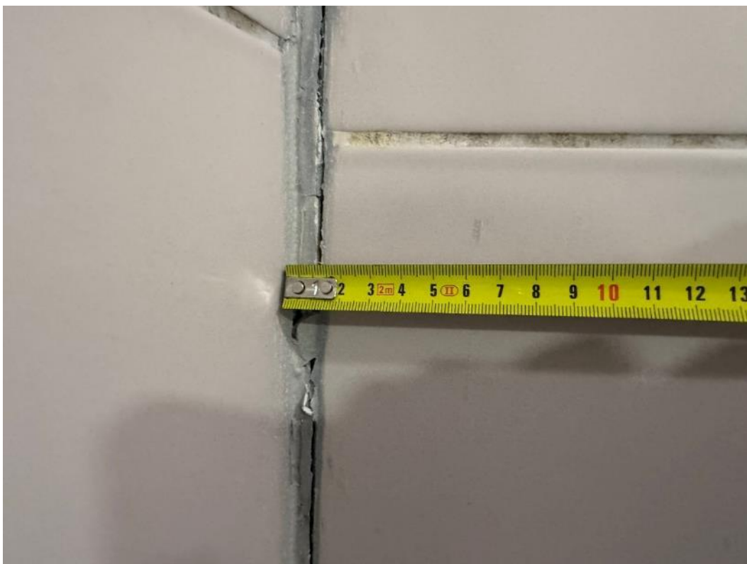
2.184 pav. Pažeistas hermetikas
