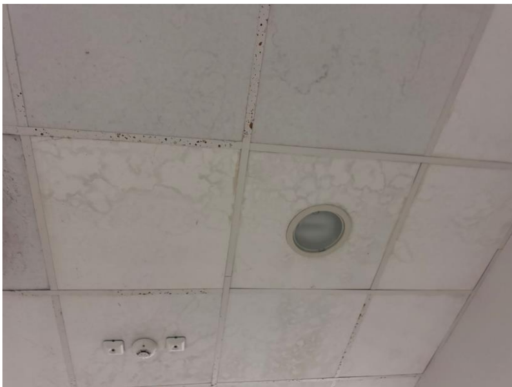
2.8 pav. Drėgmės pažeistos lubos
