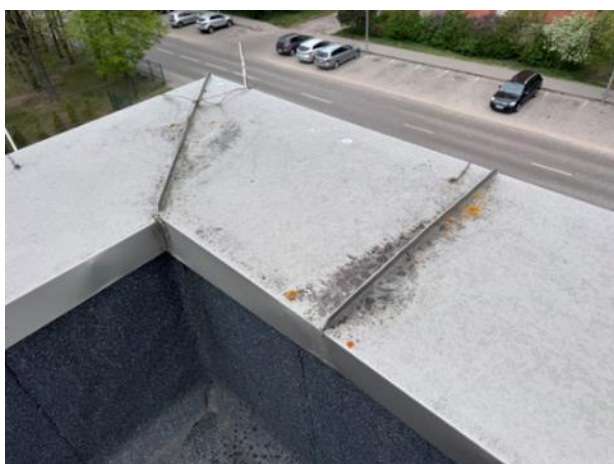
3.16 pav. Drėgmės paveikti parapetų apskardinimai
