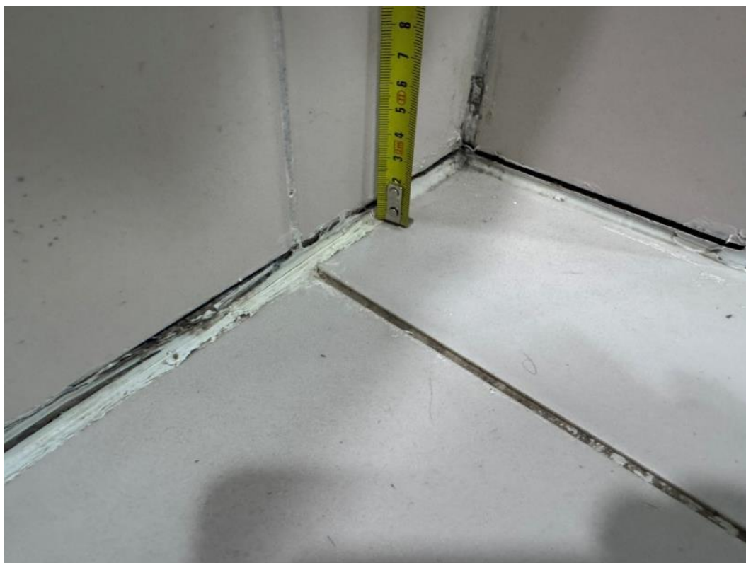
2.76 pav. Pažeistas hermetikas
