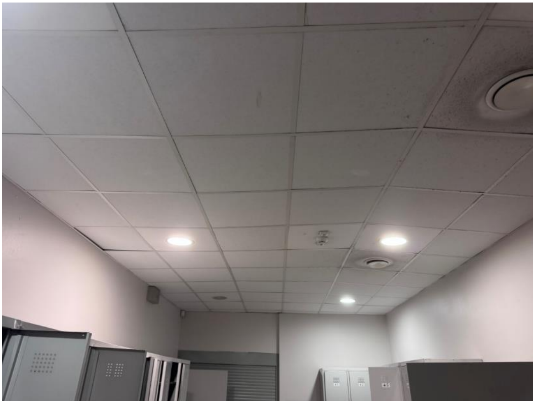
2.168 pav. Drėgmės pažeistos lubos
