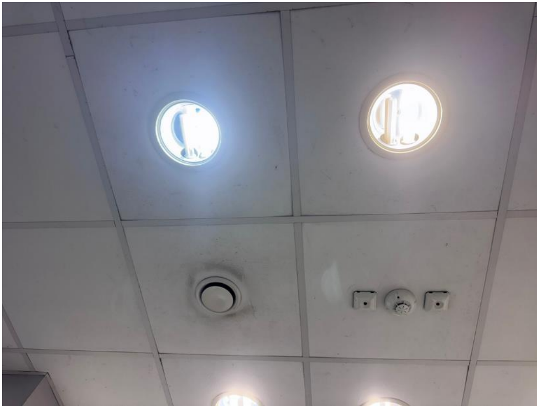
2.229 pav. Drėgmės pažeistos lubos
