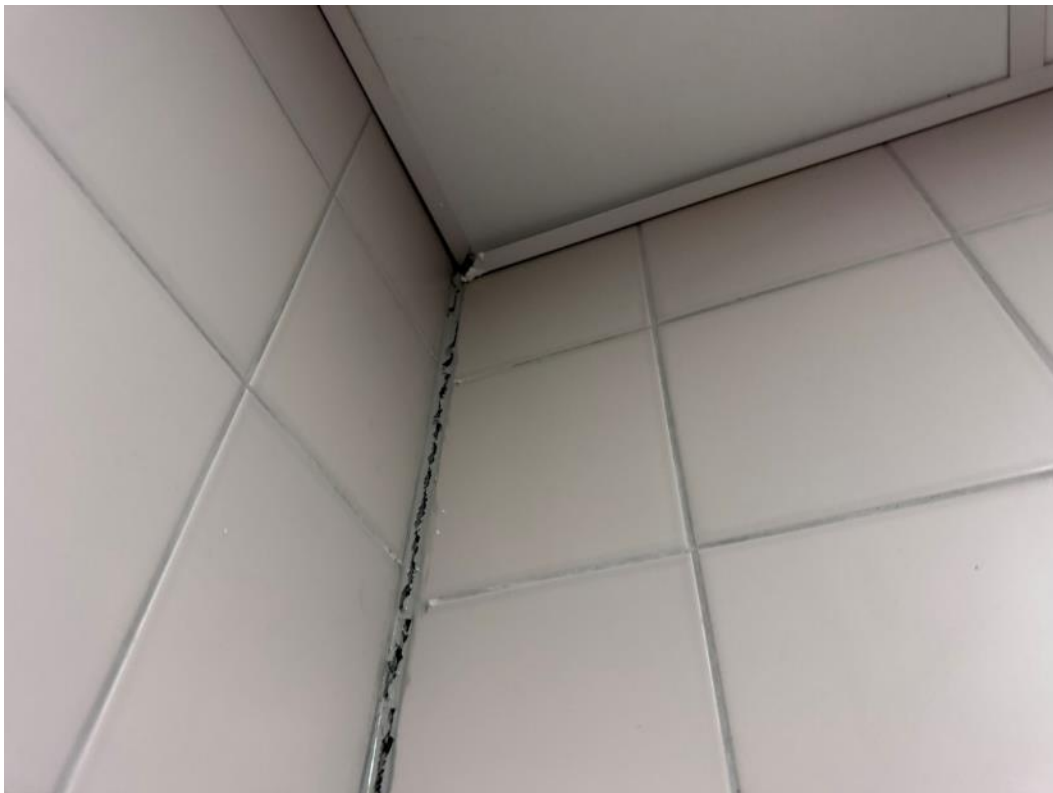
2.214 pav. Pažeistas hermetikas
