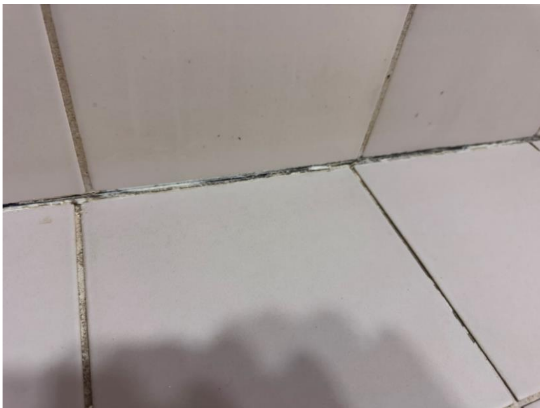
2.84 pav. Pažeistas hermetikas
