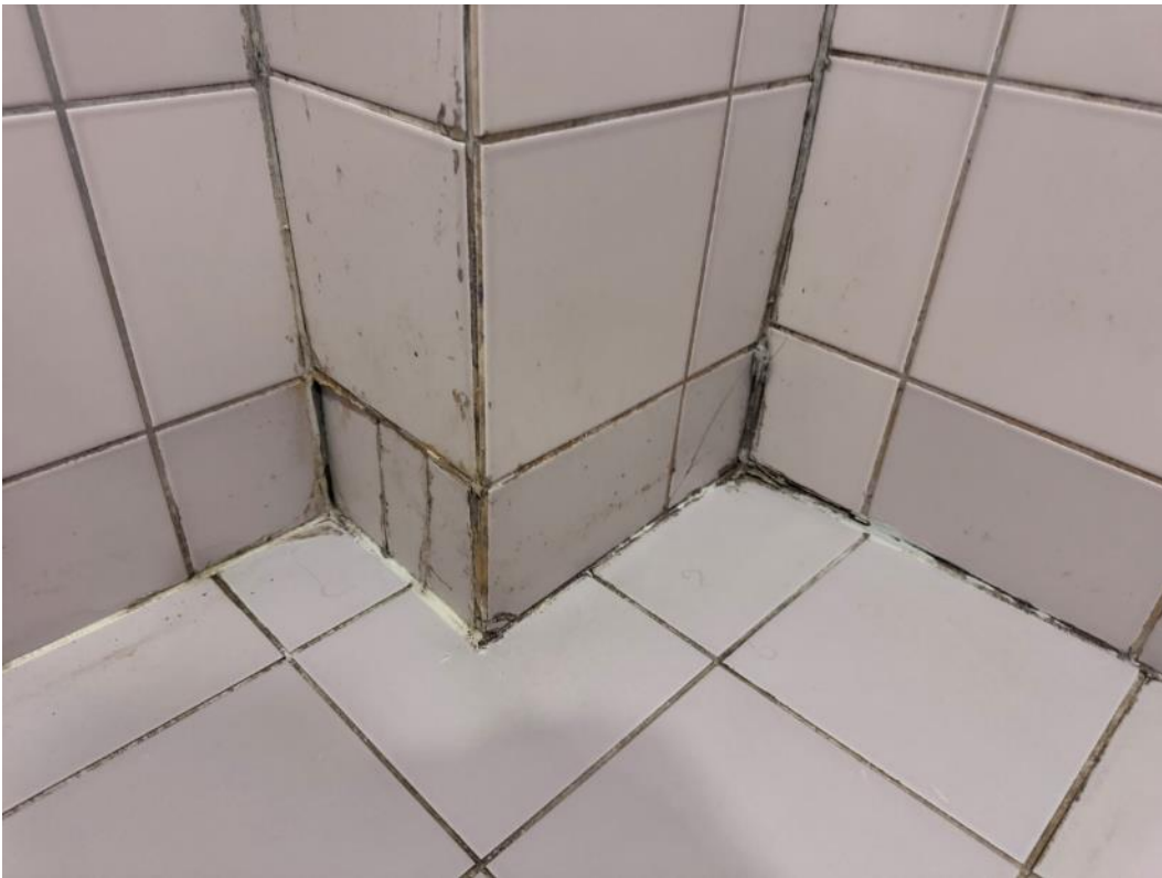
2.191 pav. Pažeistas hermetikas
