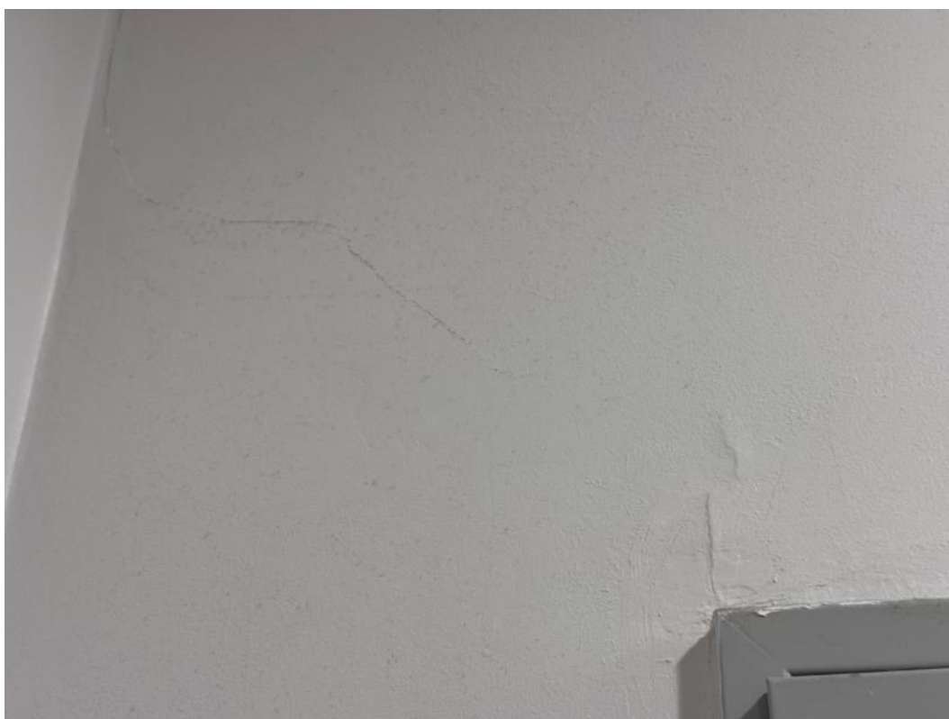
2.114 pav. Sutrūkusi sienos apdaila
