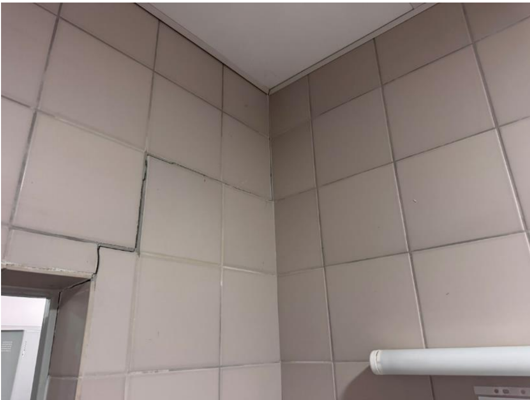
2.218 pav. Apgadinta plytelių apdaila
