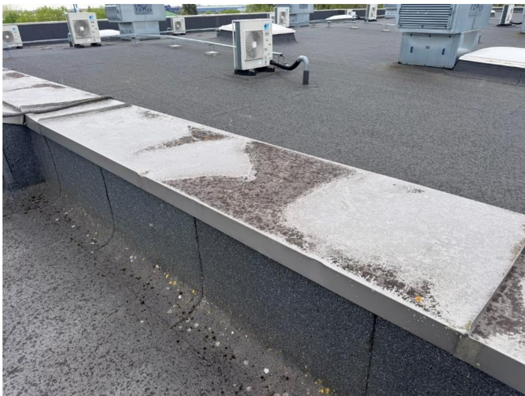
2.329 pav. Drėgmės paveikta parapeto skarda
