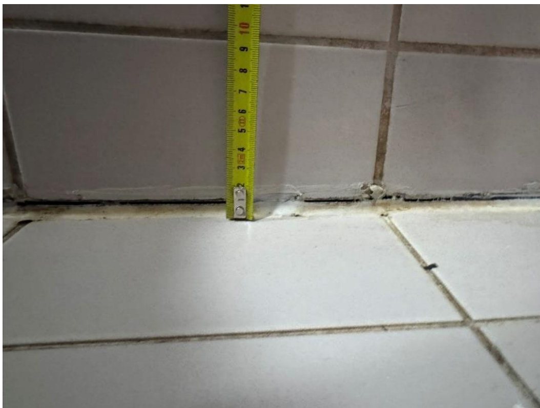
2.298 pav. Pažeistas hermetikas, susmukusios grindys
