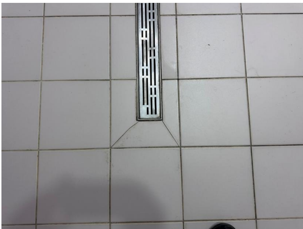
2.41 pav. Sutrūkusi plytelių apdaila
