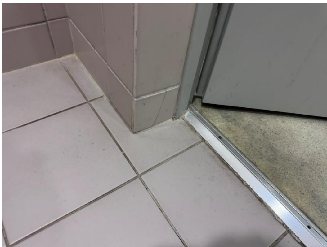
2.311 pav. Sutrūkusi plytelių apdaila
