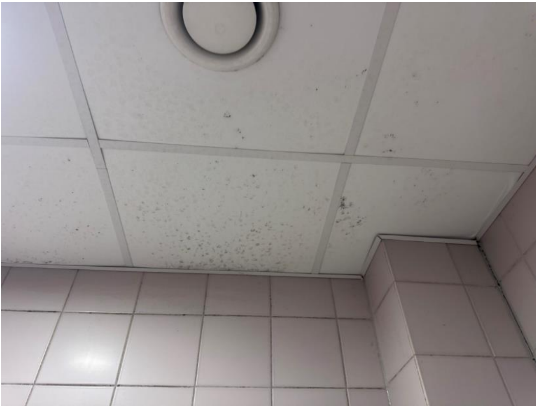
2.197 pav. Drėgmės pažeistos lubos
