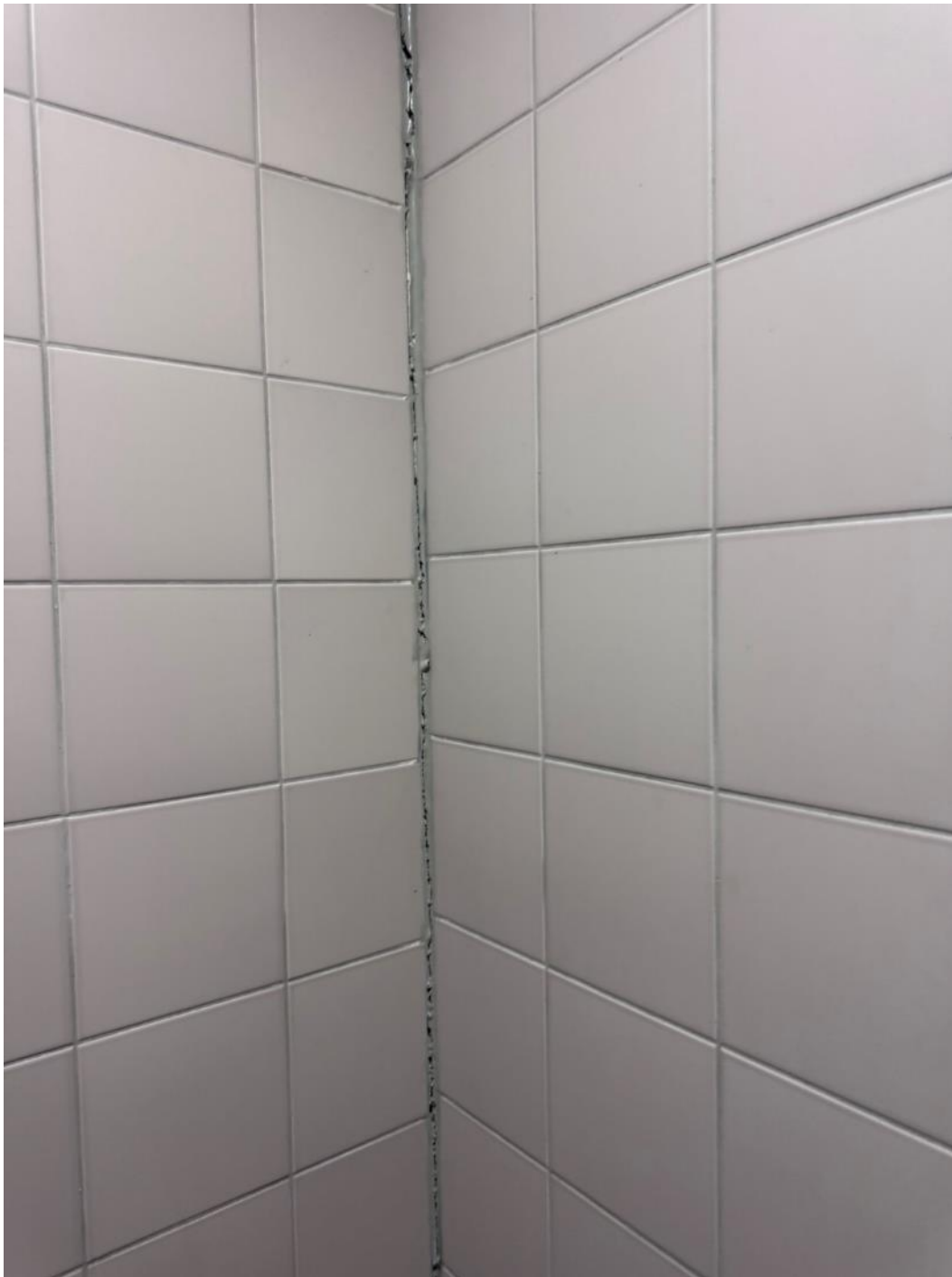
2.219 pav. Pažeistas hermetikas
