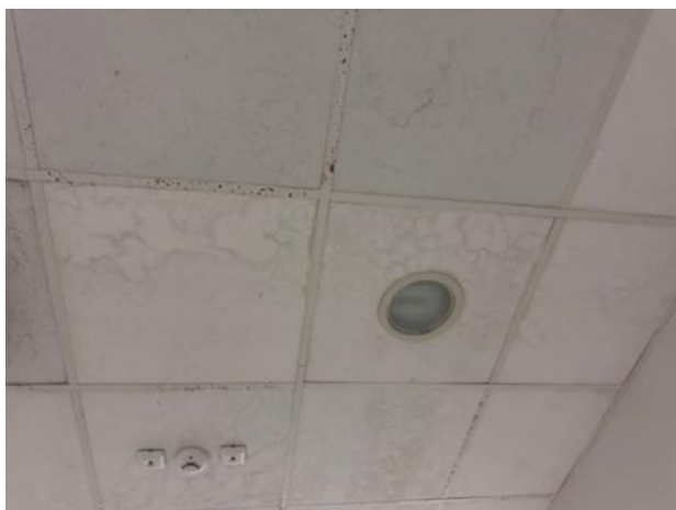
3.2 pav. Drėgmės pažeistos lubos
