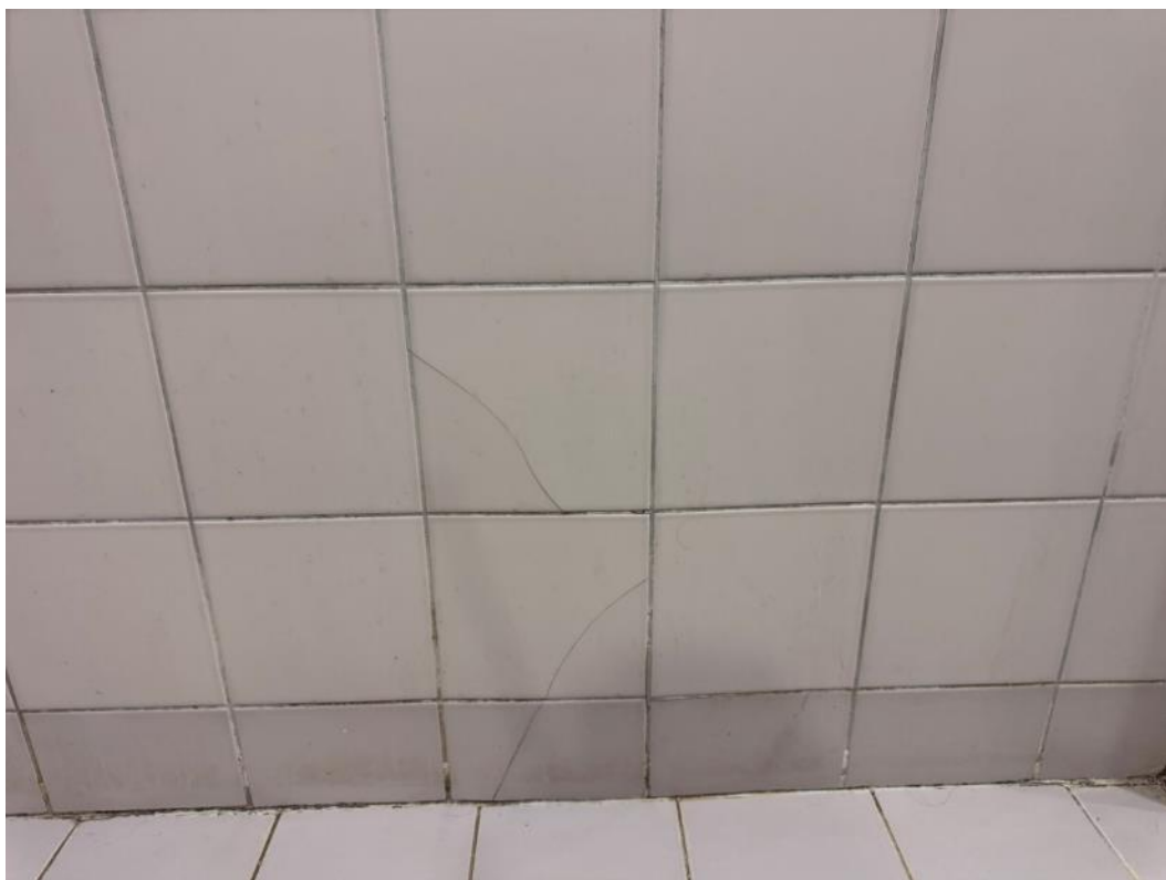
2.203 pav. Sutrūkusi plytelių apdaila
