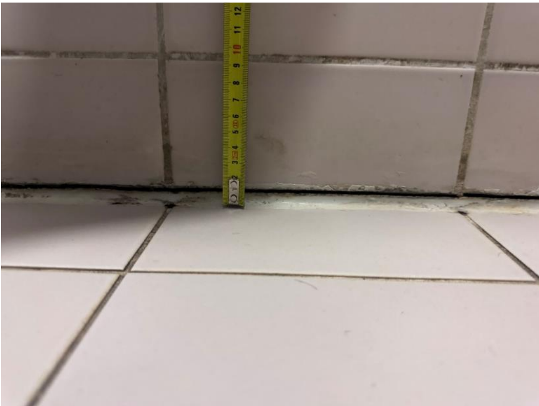
2.297 pav. Pažeistas hermetikas, susmukusios grindys
