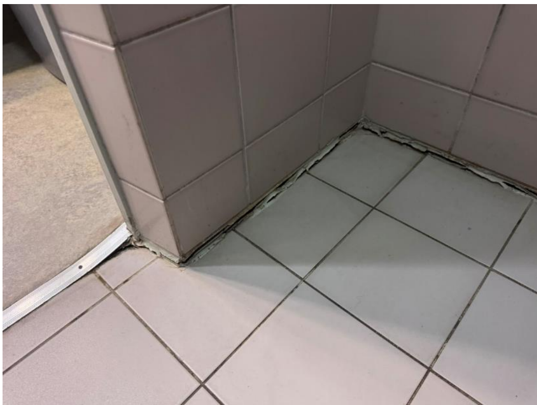
2.241 pav. Pažeistas hermetikas
