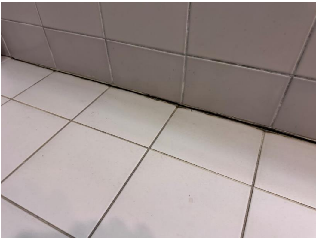
2.248 pav. Pažeistas hermetikas
