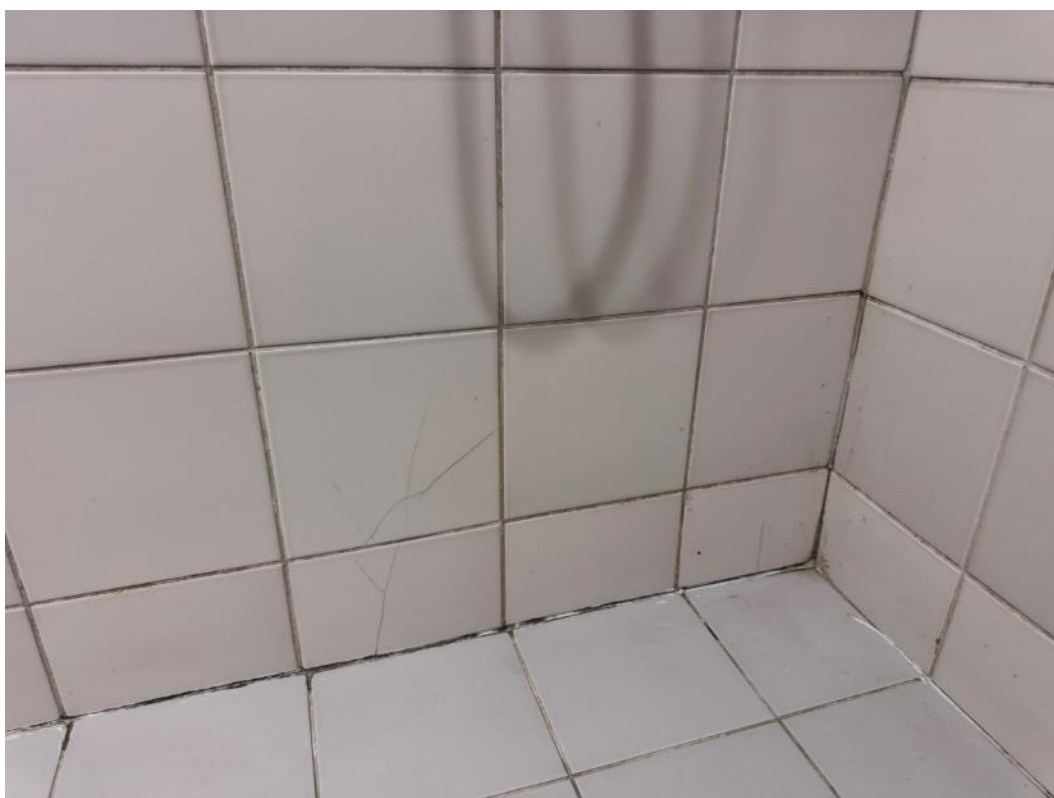
2.45 pav. Sutrūkusi plytelių apdaila
