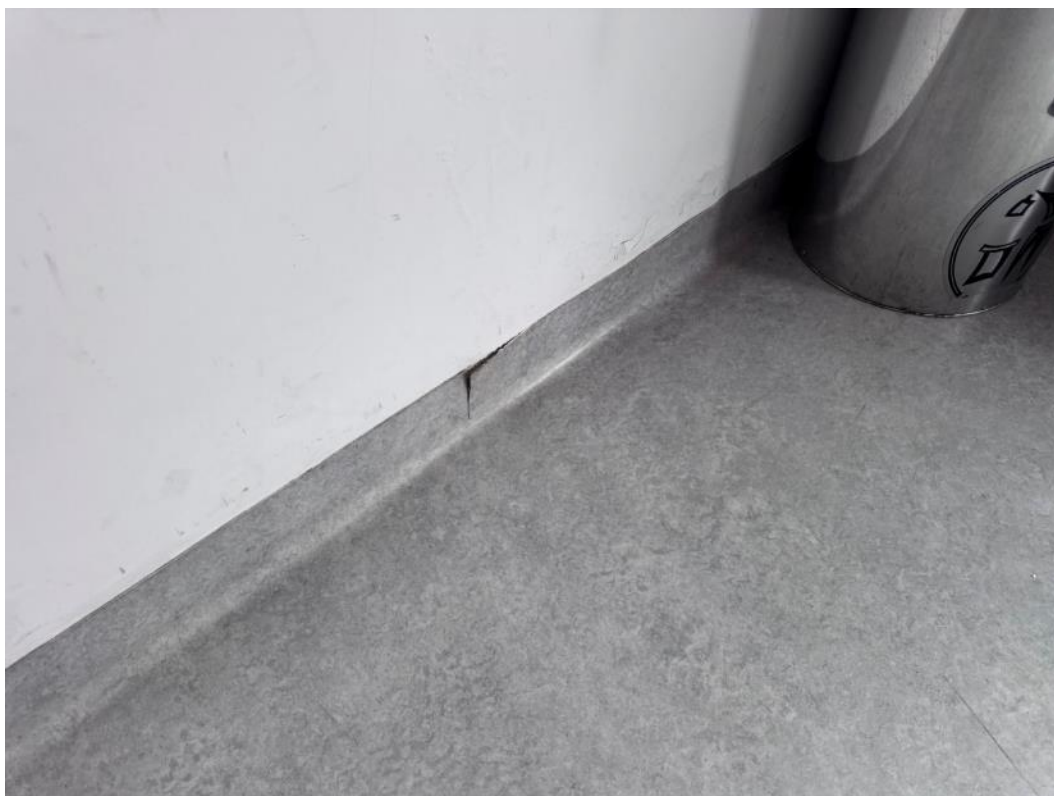
2.273 pav. Apgadintos grindjuostės
