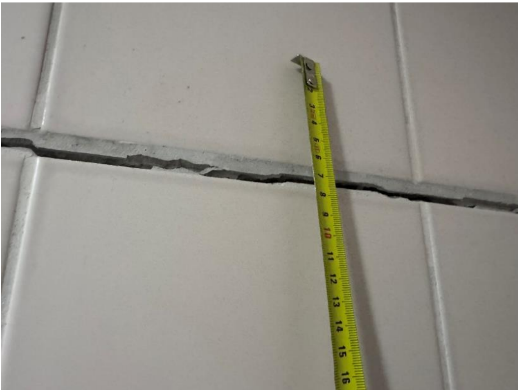
2.216 pav. Apgadinta plytelių apdaila
