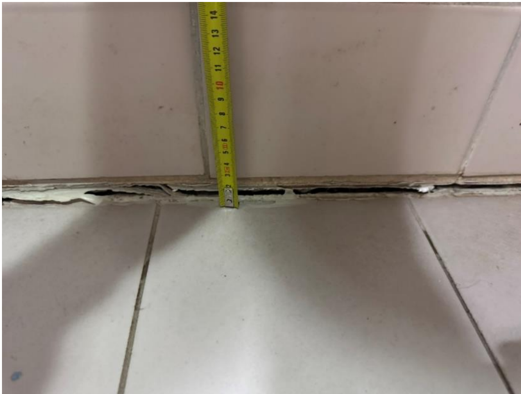
2.243 pav. Pažeistas hermetikas
