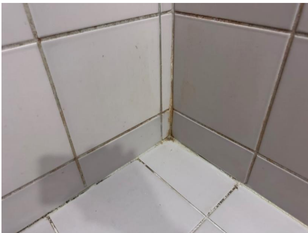
2.299 pav. Pažeistas hermetikas
