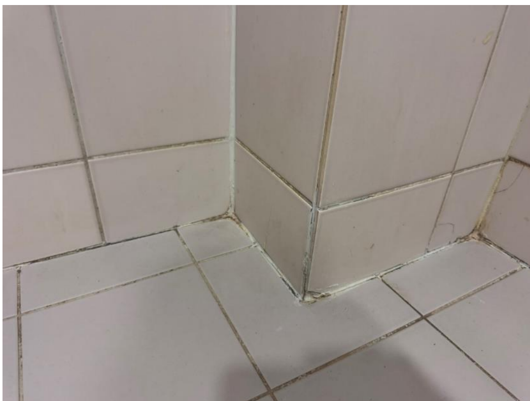
2.79 pav. Pažeistas hermetikas
