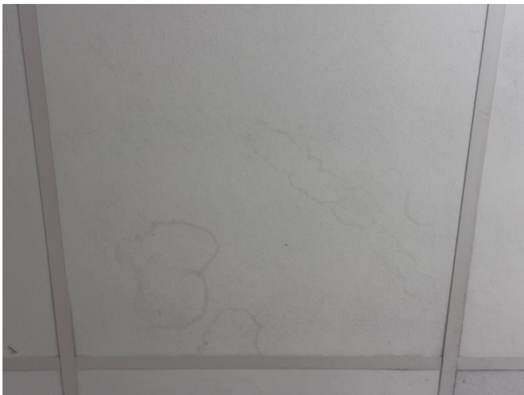
2.58 pav. Drėgmės pažeistos lubos
