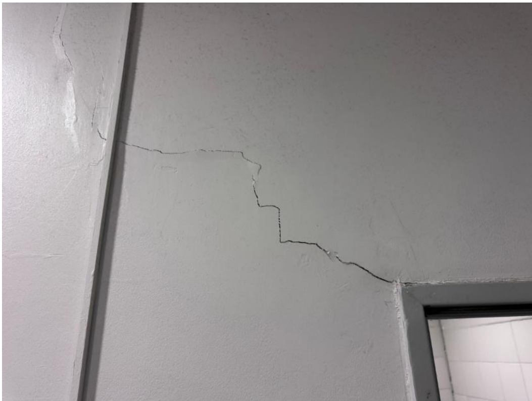
2.164 pav. Sutrūkusi sienos apdaila
