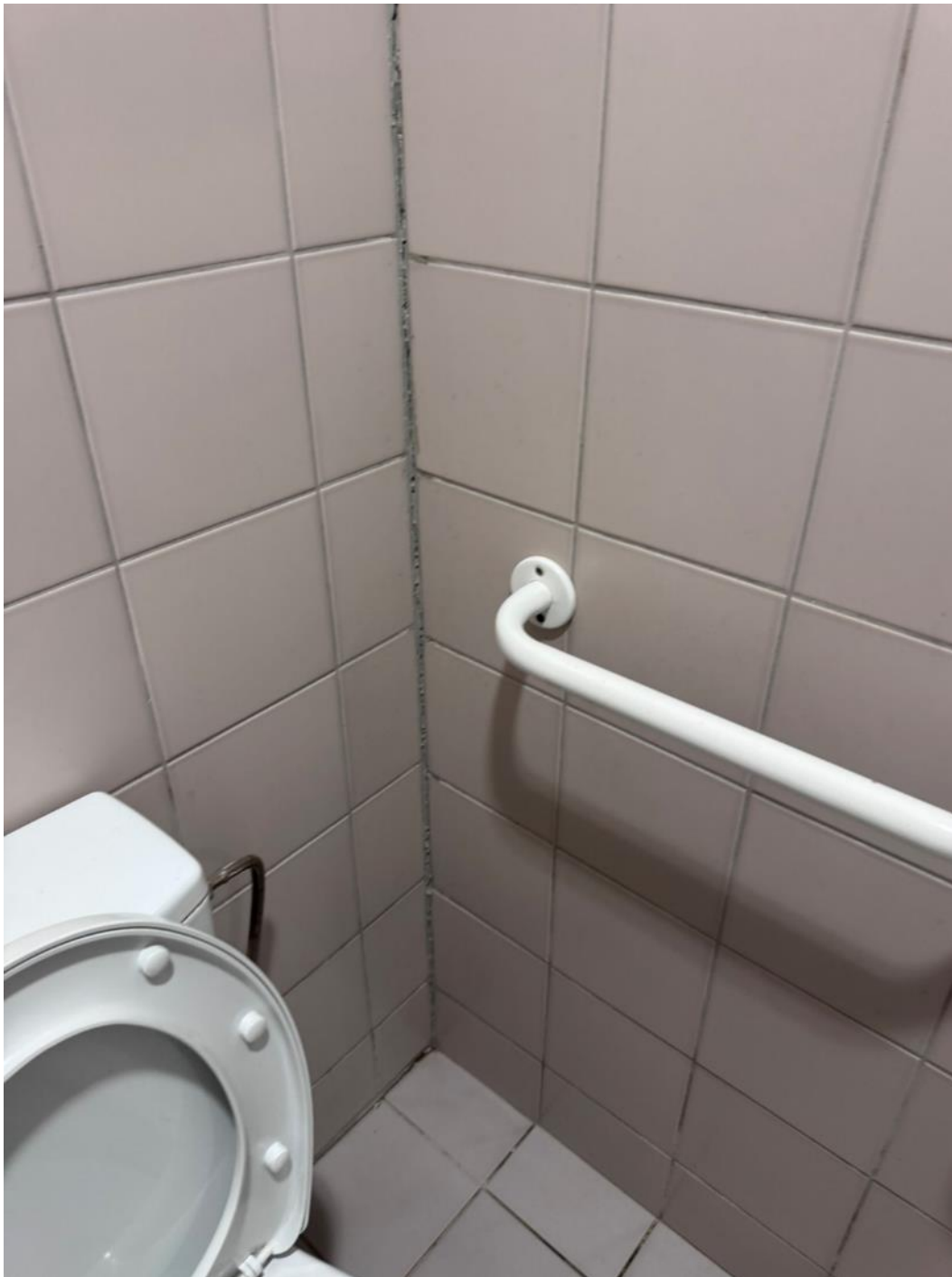
2.131 pav. Pažeistas hermetikas
