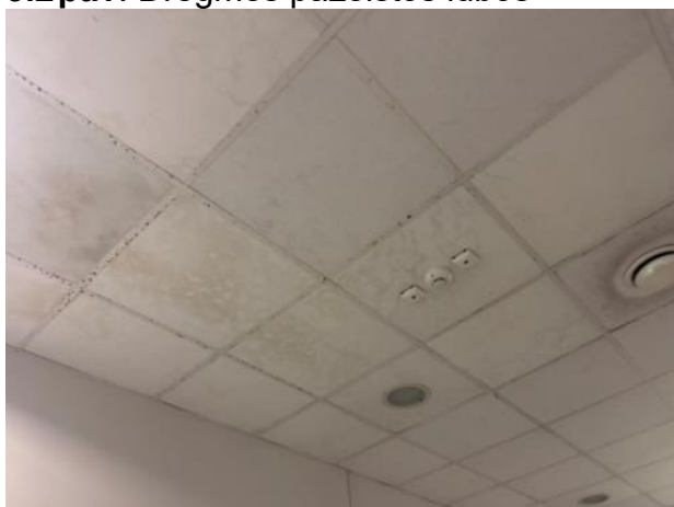
3.2 pav. Drėgmės pažeistos lubos
