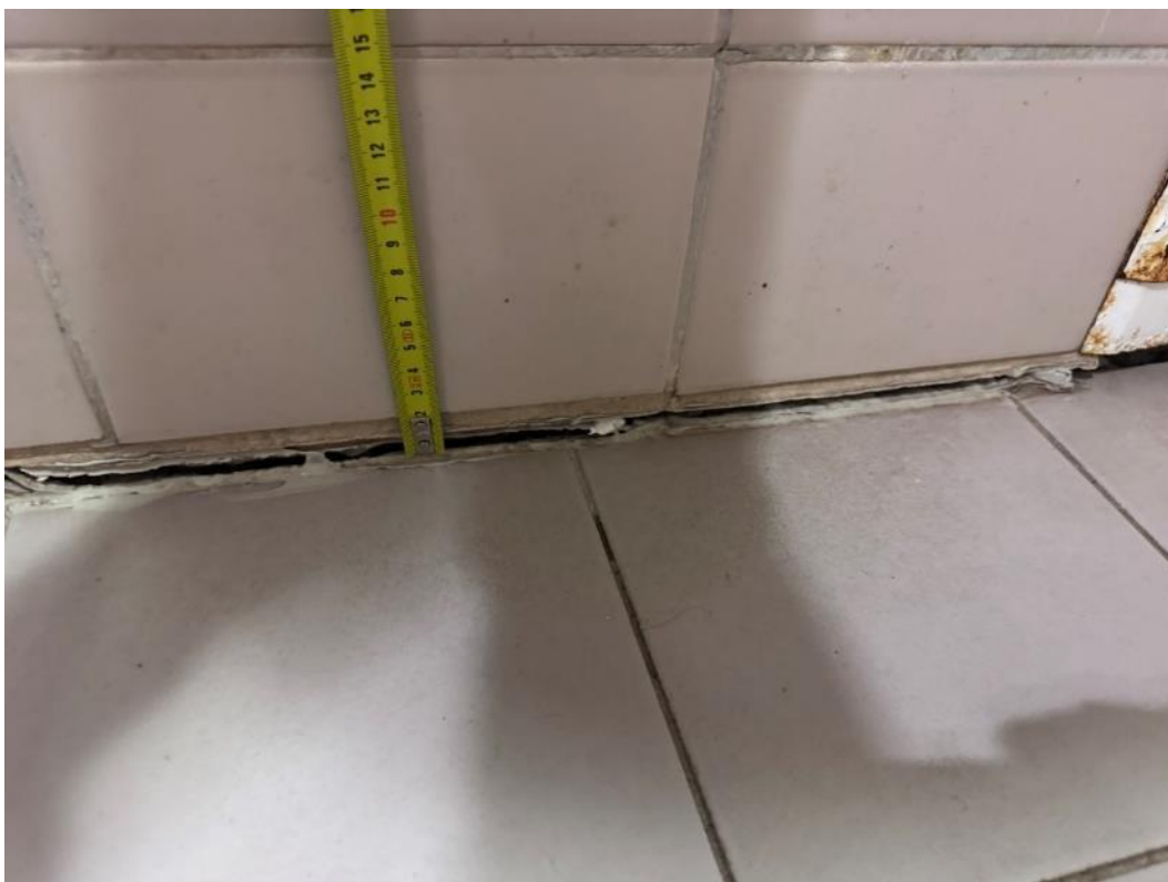
2.244 pav. Pažeistas hermetikas
