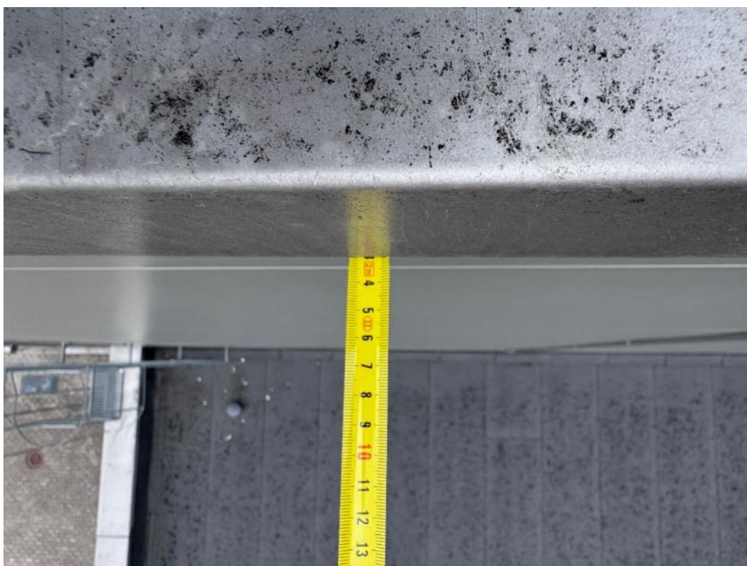
2.353 pav. Apskardinio išsikišimas (~3,1cm)
