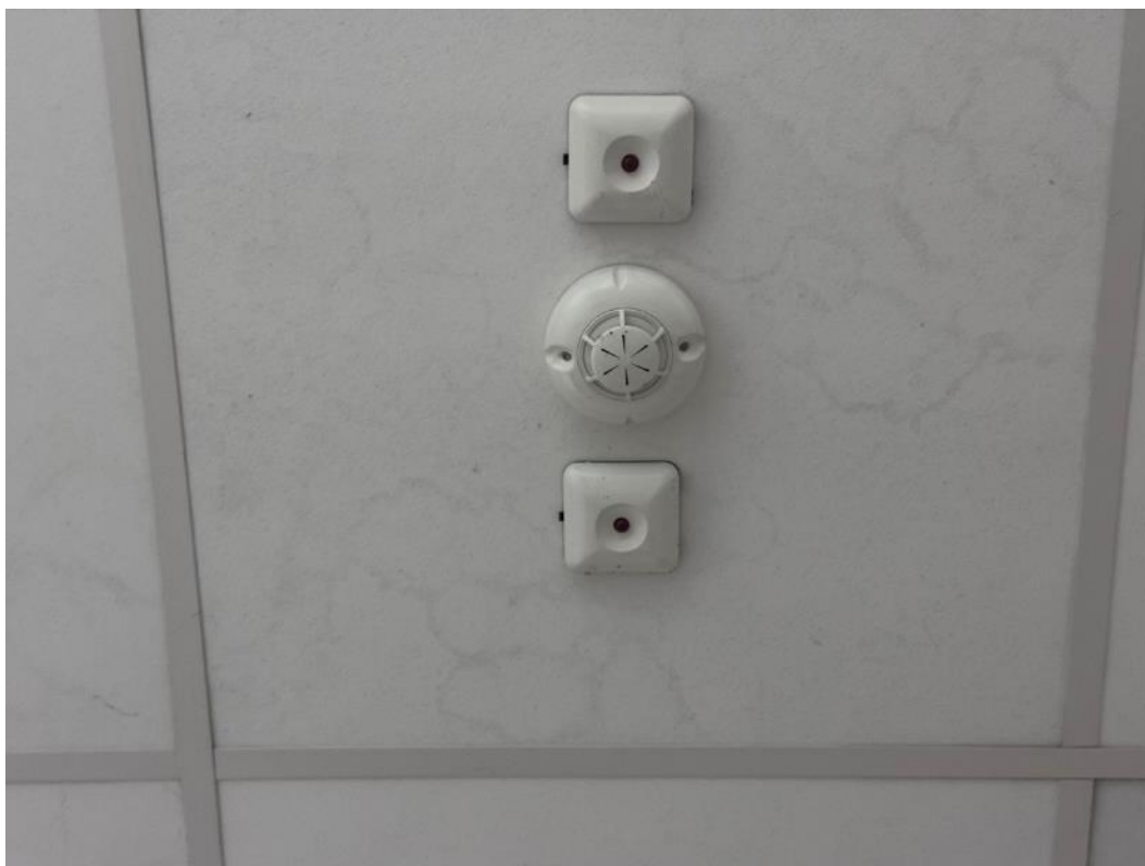
2.54 pav. Drėgmės pažeistos lubos
