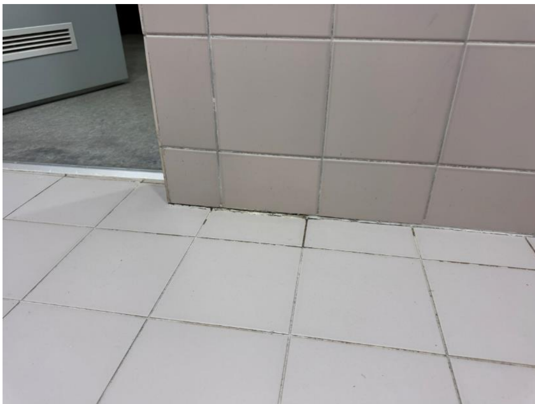
2.80 pav. Pažeistas hermetikas
